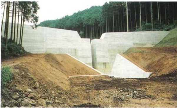
原入沢 砂防堰堤 (裾野市 深良)
