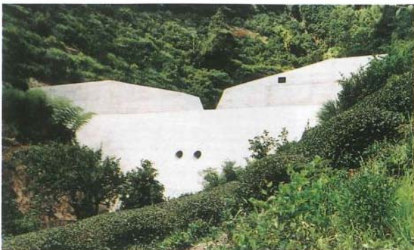
岡部川水系赤目沢砂防堰堤 (岡部町岡部)
