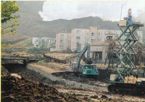
西山川 無人化機械施工の実地状況
