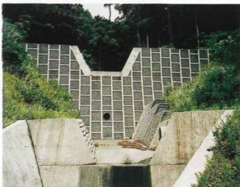
大井川水系高越沢砂防ダム (島田市 赤松)
