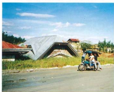
泥流で埋没したバコロール市街地（土砂は約6m堆積）
