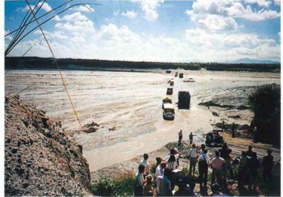
バシグ川の土砂堆積状況、橋は流失し通行車両は河床を走行している
