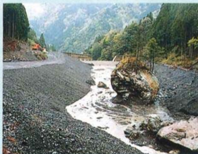
除石工事の完了状況(平成11年6月)
