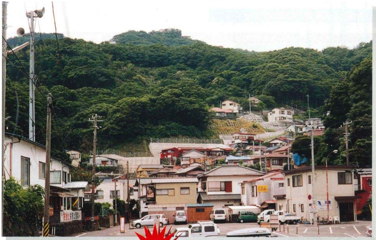
川奈小浦台急傾斜地 (伊東市)
