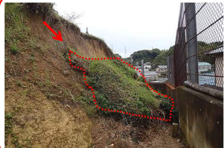
がけ崩れ発生直後 (H29.10.25)
