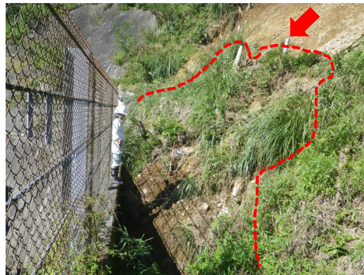
がけ崩れ発生直後 (H29.10.23)
