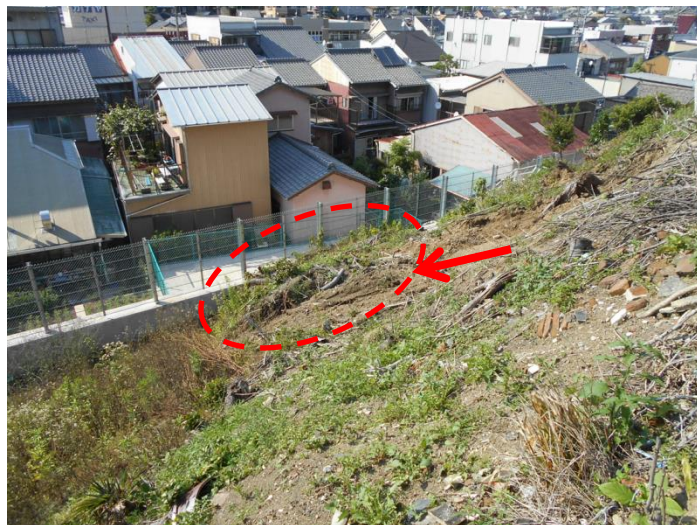
がけ崩れ発生直後 (H29.6.23)
