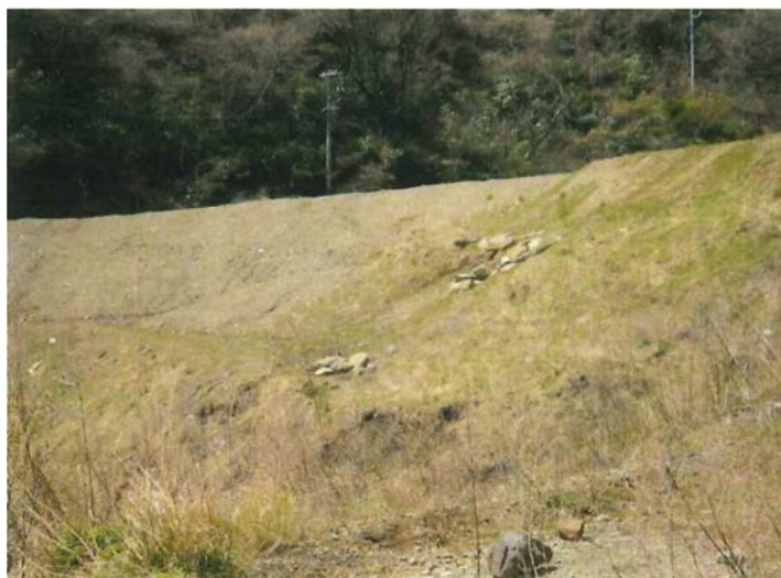
法面の緑化状況
