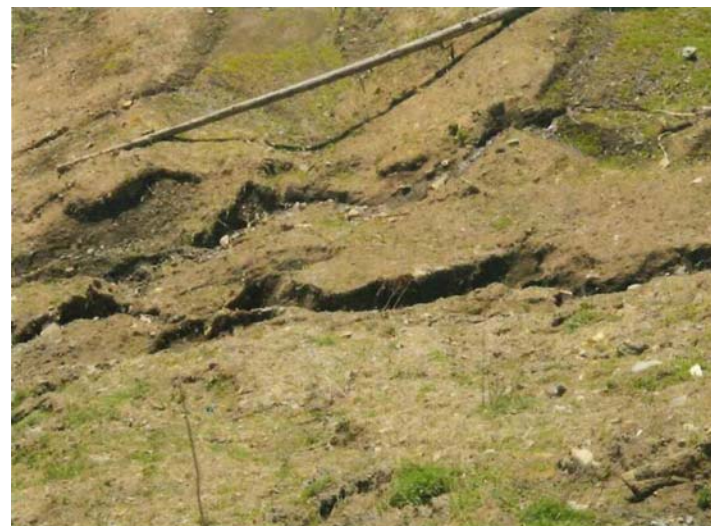
法面の浸食発達状況
