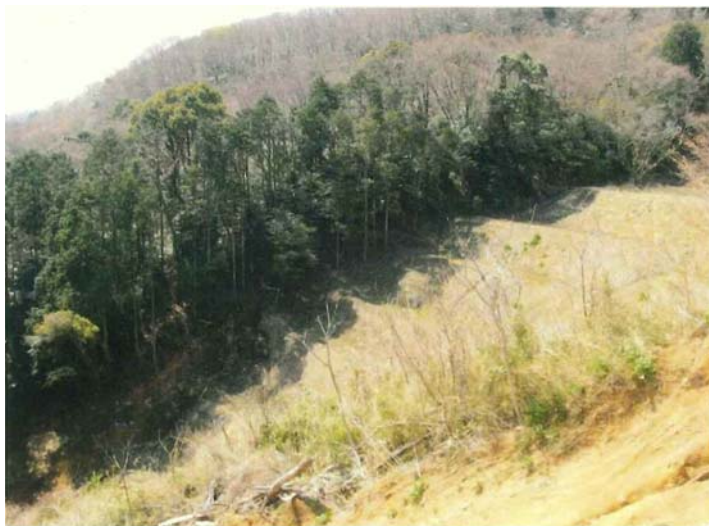
残土による盛土法面
