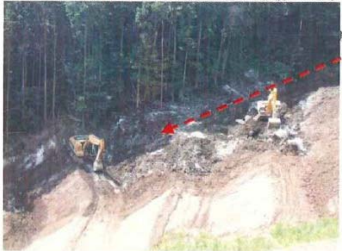
残土の状況。20~30cm程度の木の棒がかなり混入している。
