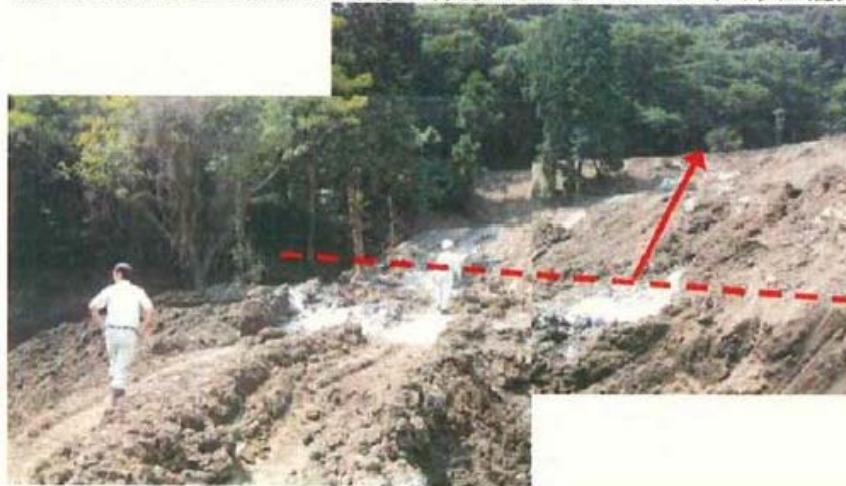
崩れた場所から上段を望む。赤い線あたりから上の土に木くずが混入している。
