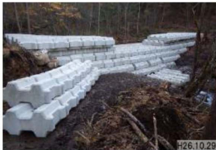
ブロック積による仮設の堰堤
