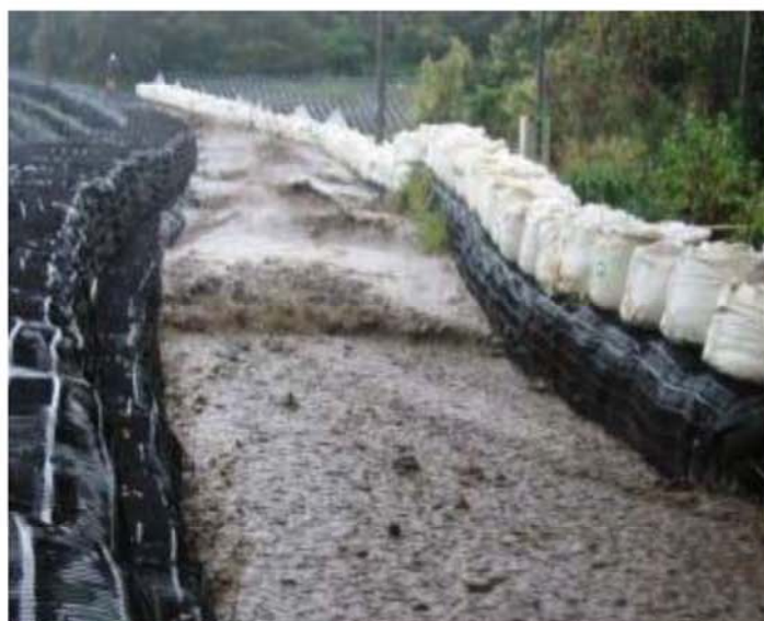
仮設導流堤を流れる泥流 (三宅島)
