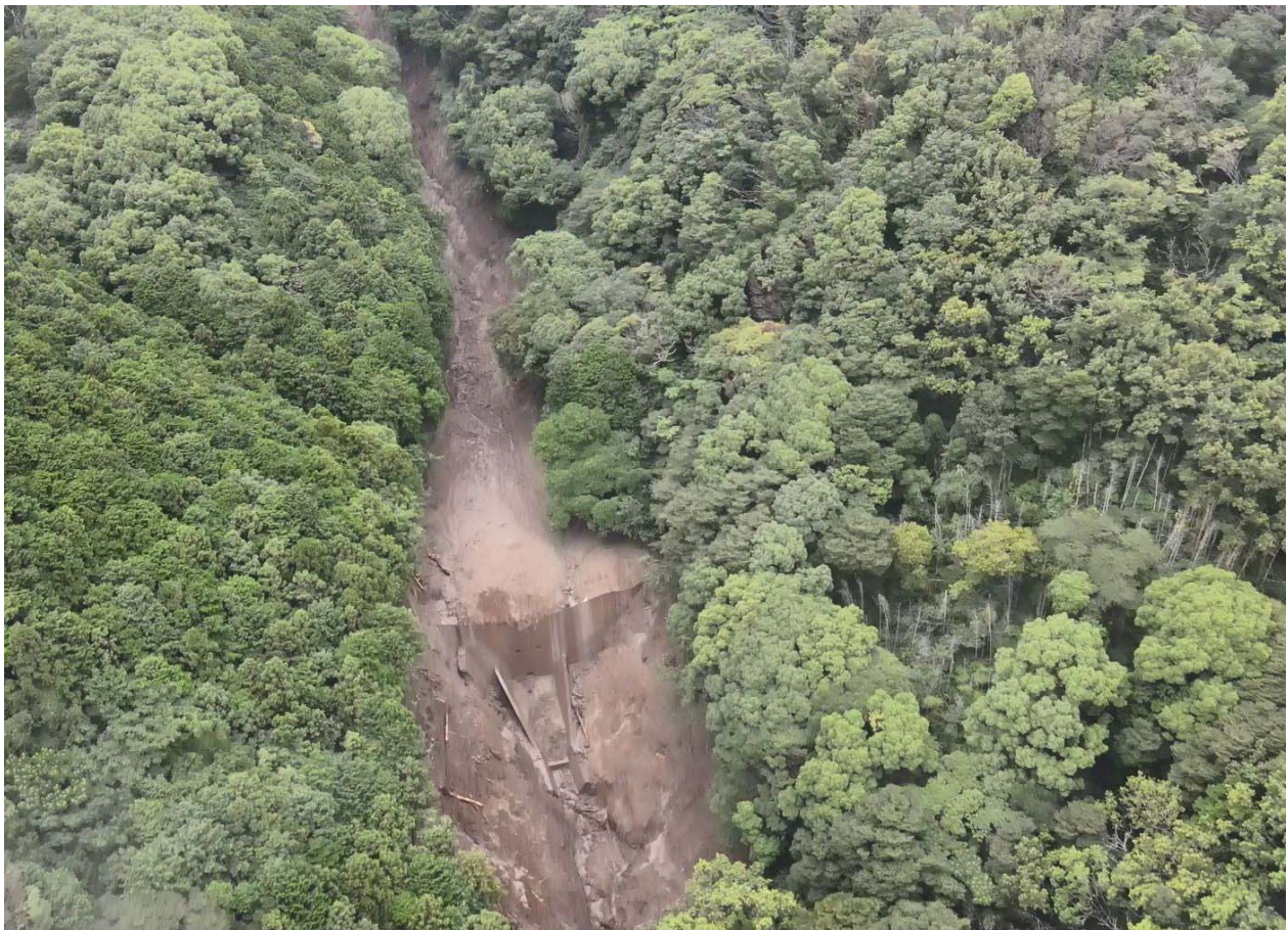
砂防堰堤堆砂状況
