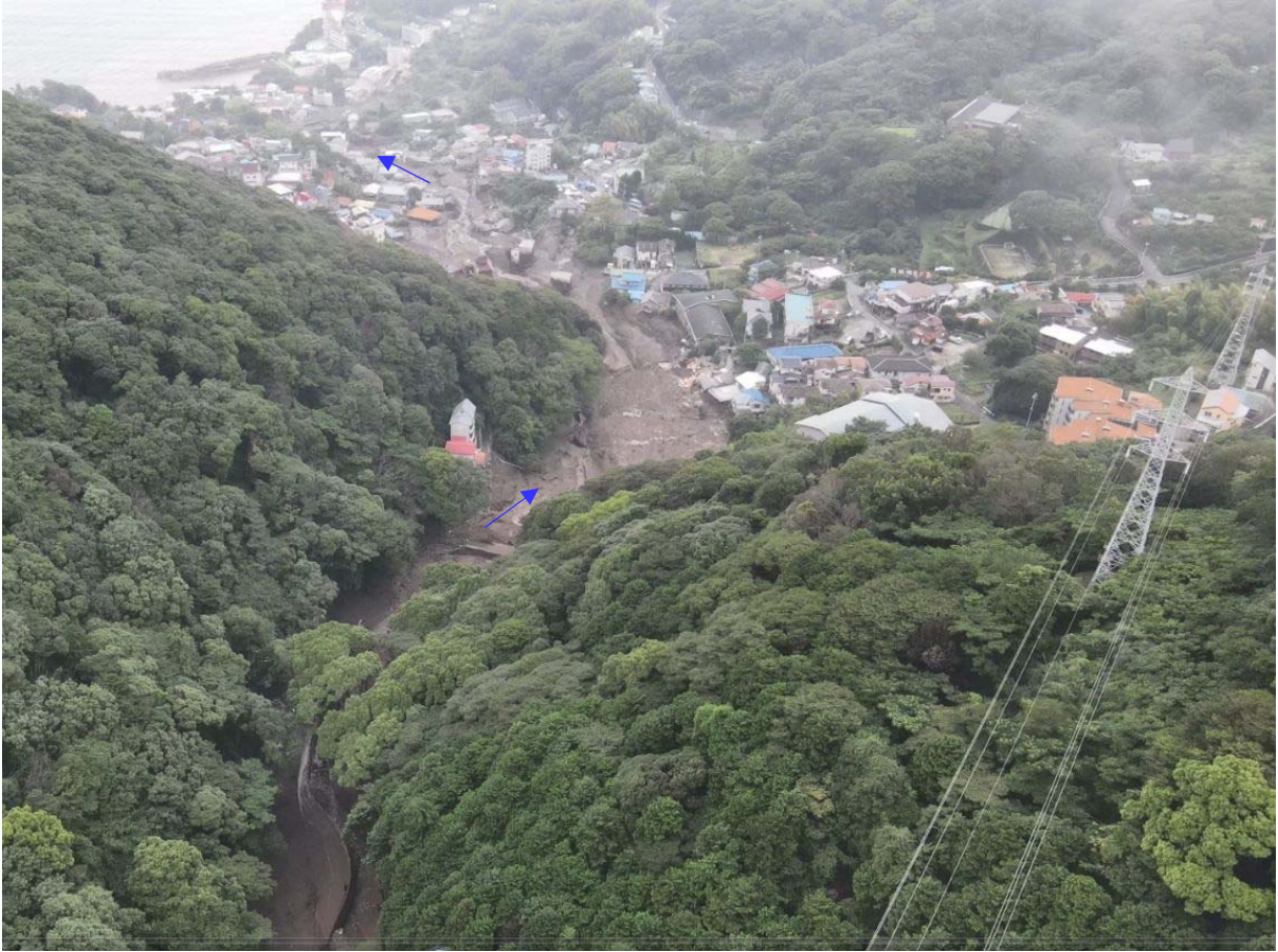
土砂流出状況
