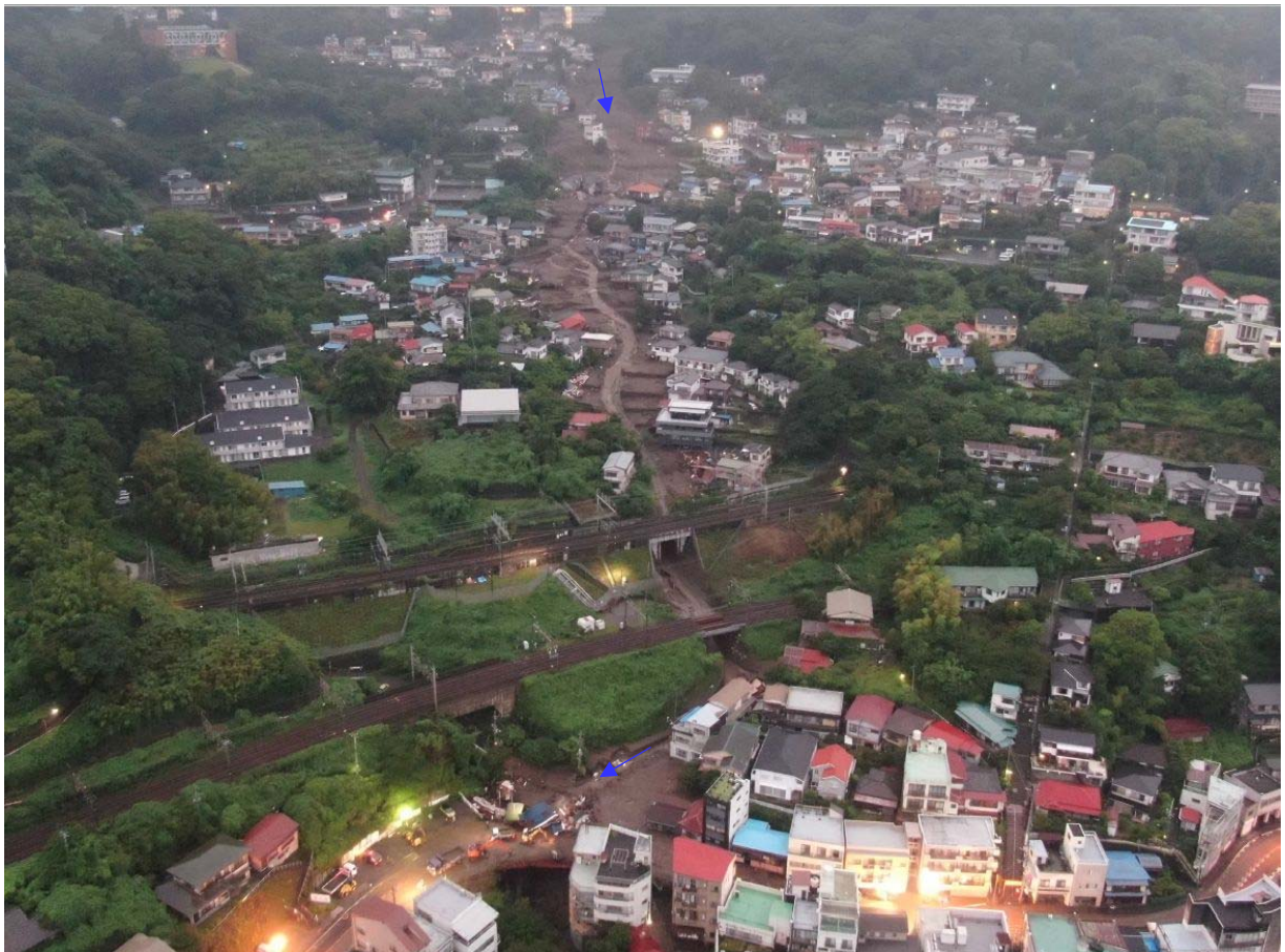
土砂流出状況
