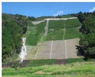
工事完成（撮影日：H30. 10）
