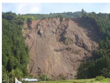
崩壊後（撮影日：H25. 7）
