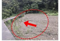
静岡市駿河区青沢 「殿谷川砂防堰堤」(全景) 【約2,000m3の土石流を捕捉】
