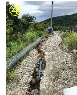
雨水は逢初川ではなく、側溝を通じてその北側の鳴沢川に流入
