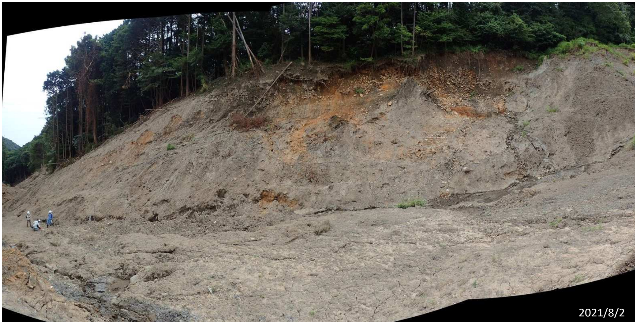
08 盛土末端付近。造成時の申請図面によれば、この付近に土堰堤と沈砂地を2列設置することになっているが、現在ではその痕跡は把握できない。
