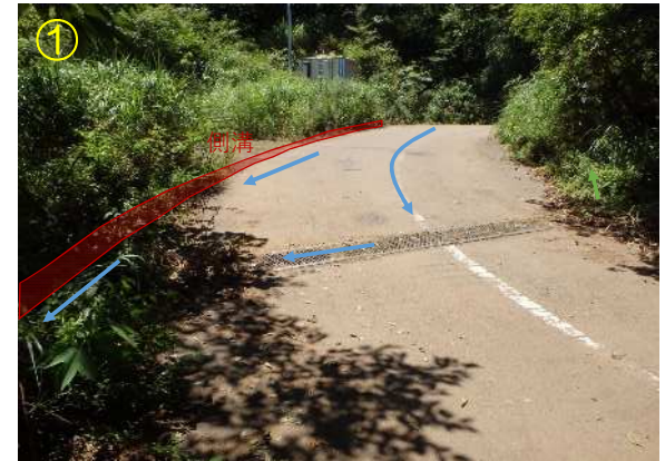
雨水は逢初川ではなく、その北側の鳴沢川に流入
