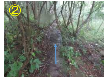
雨水は逢初川ではなく、側溝を通じてその北側の鳴沢川に流入
