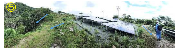
雨水は太陽光発電設備設置地の南側の溪流に流入 表流水は逢初川源頭部には流れていない
