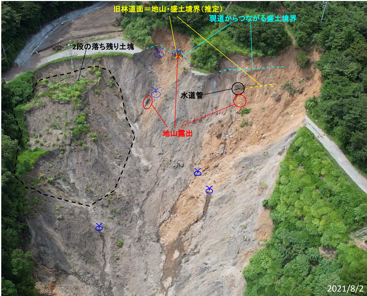
01 崩壊地全景。崩壊直後の動画に見られた大量の出水は、七尾調圧槽からつながる水道管の破断によるものである。水道管は旧林道の高さであり、それより下位は地山と判断される。また現道の高さにも盛土の境界があり、別時期に造成されたと推定される。
