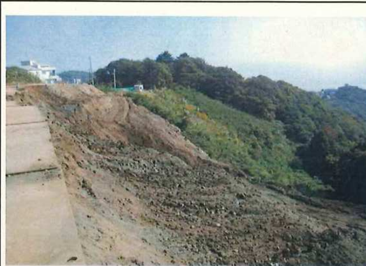
②赤井谷の埋め立て状況(①とは反対側より)
