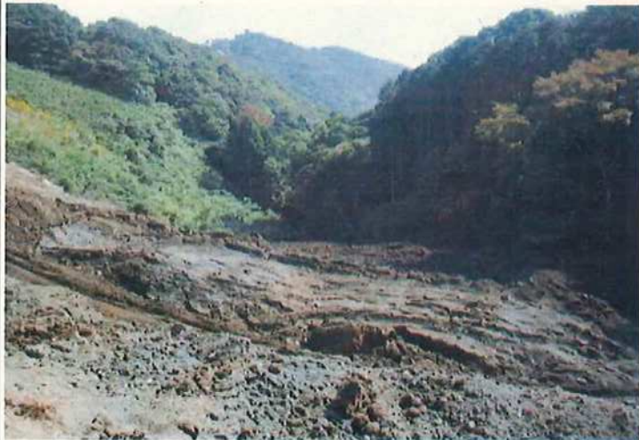
④谷底の埋め立て状況 (大規模な流出は起きていない模様)
