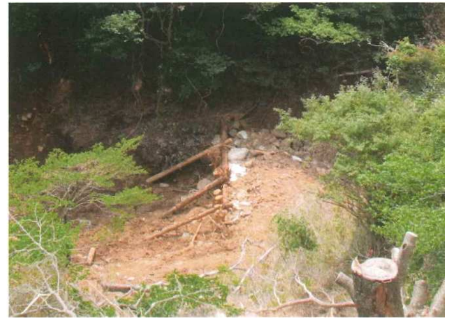
写真－2 2007年5月22日 右上：転石積の土留（申請書でいうロックフィルと思われる） 右下：丸太＋転石の土留
