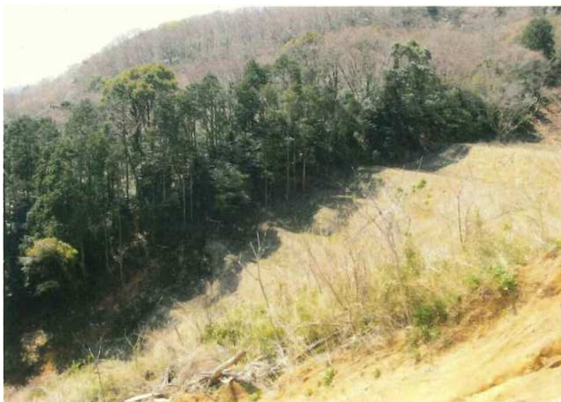
残土による盛土法面
