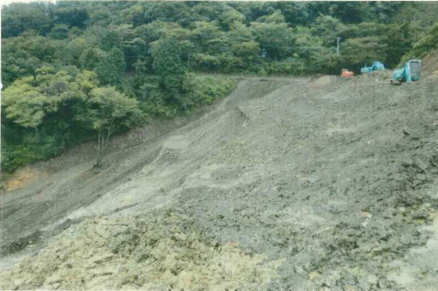
写真-4 2009年10月9日 土砂の上部からの搬入。排水工は見られない。
