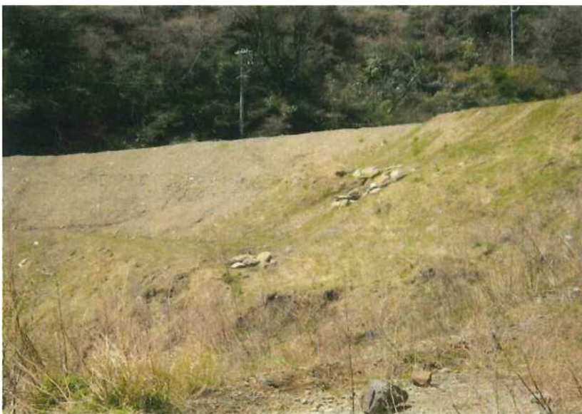
法面の緑化状況
