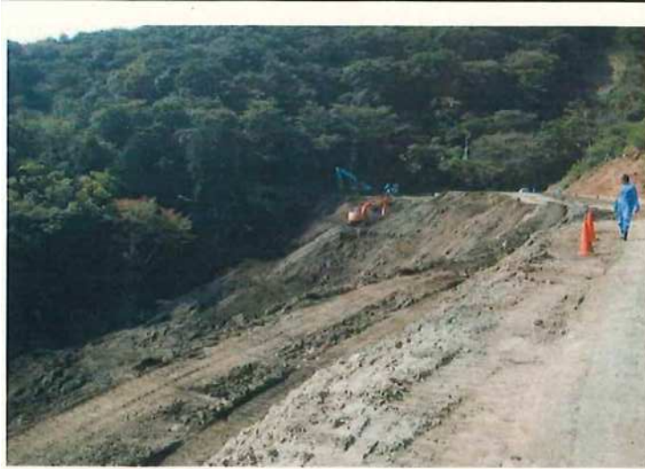
①赤井谷の埋め立て状況
