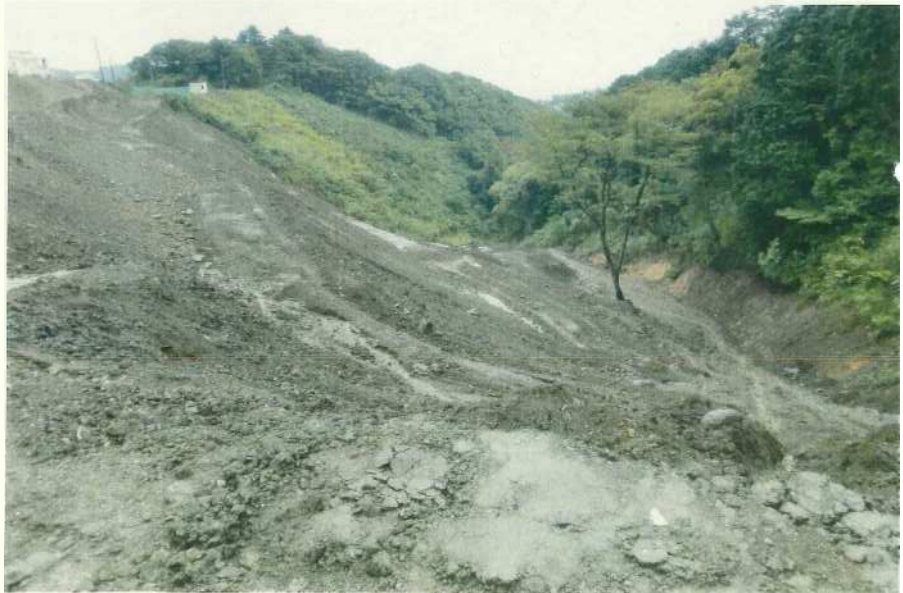
写真-4 2009年10月9日 土砂の上部からの搬入。排水工は見られない。
