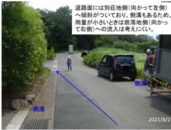
写真⑳ 崩落地左岸側の別荘地横の道路
