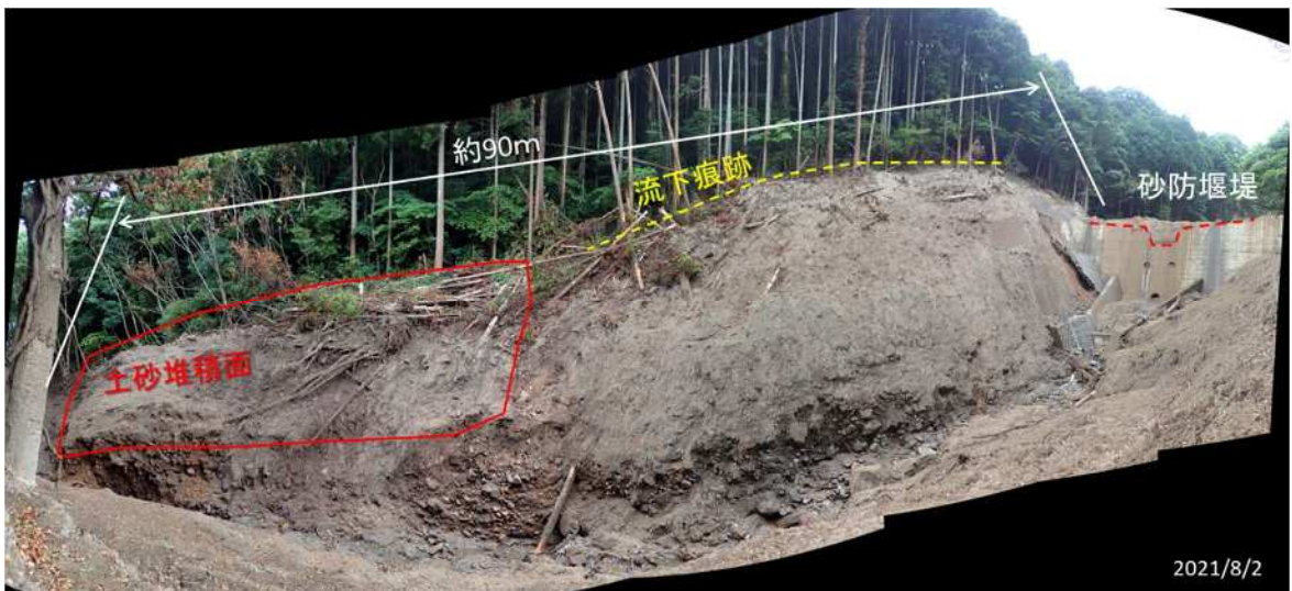
写真④ 砂防堰堤の下流右岸の流下痕跡と土砂堆積状況
