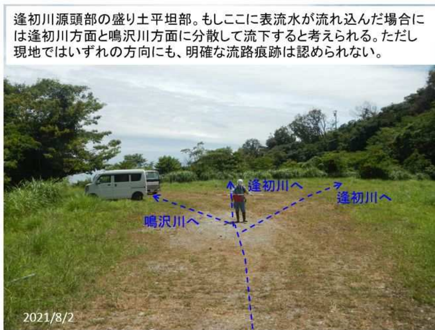
写真㉒ 逢初川源頭部の盛り土平坦部
