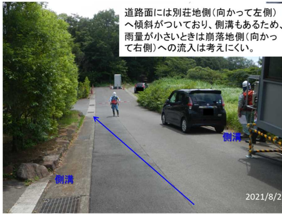
写真⑬ 崩落地左岸側の別荘地横の道路
