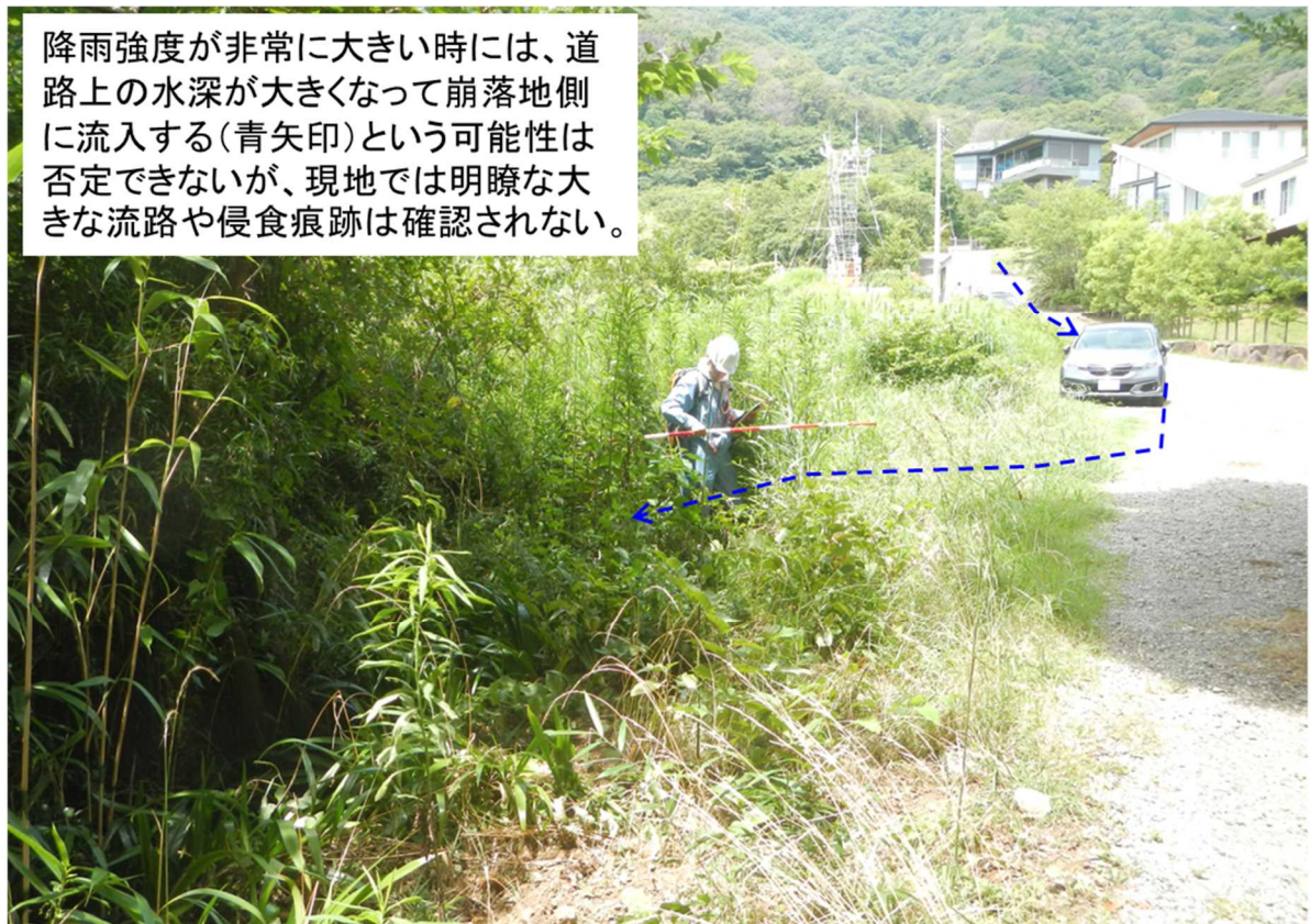
写真⑫ 崩落地左岸側尾根上の道路
