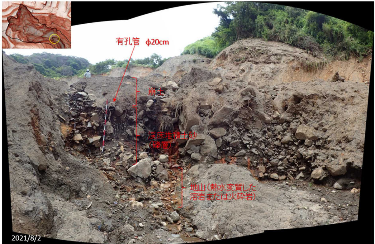
写真⑪ 崩落地下端付近に見られる有孔管
