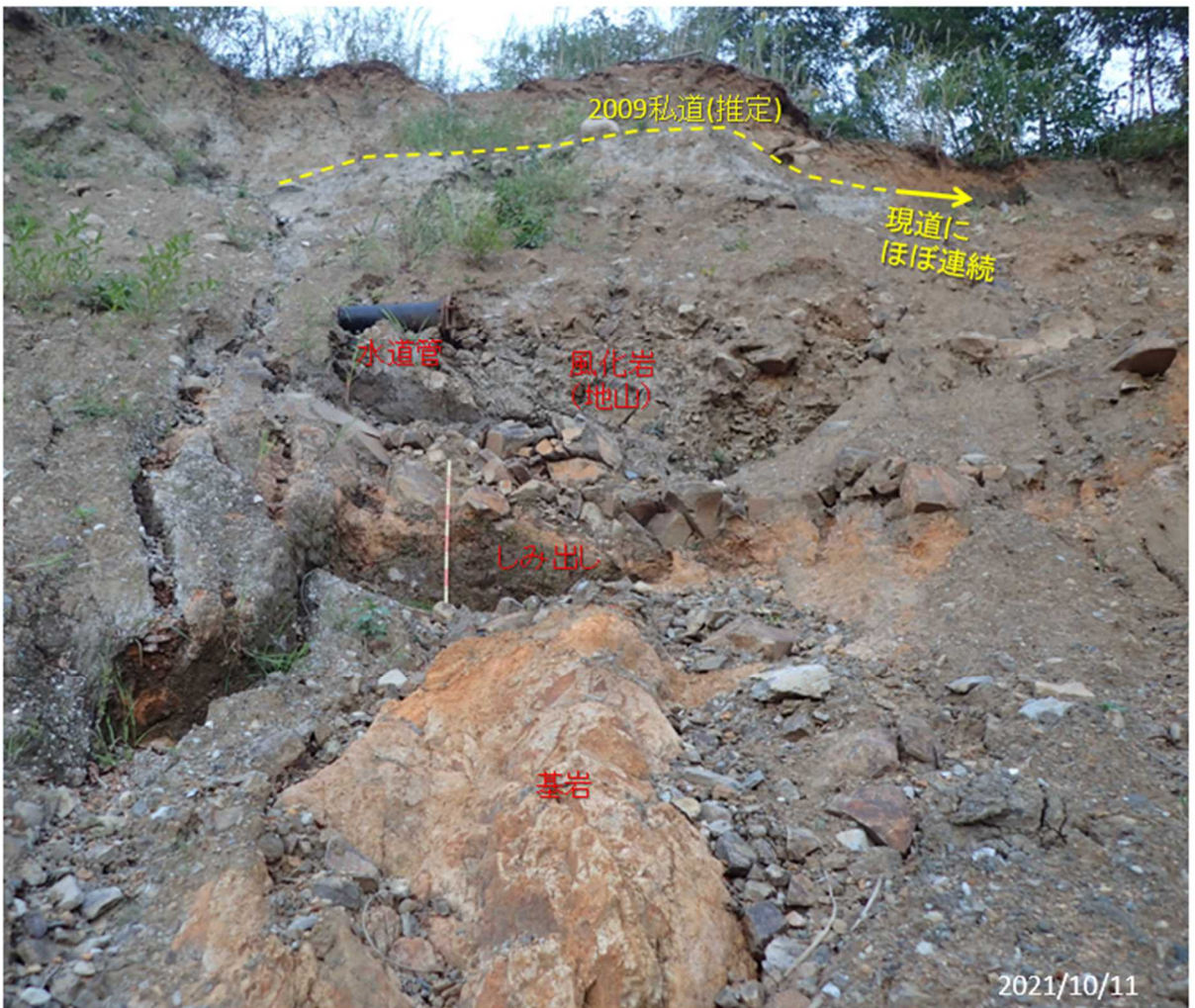
写真④ 左岸側崩落地の露頭
