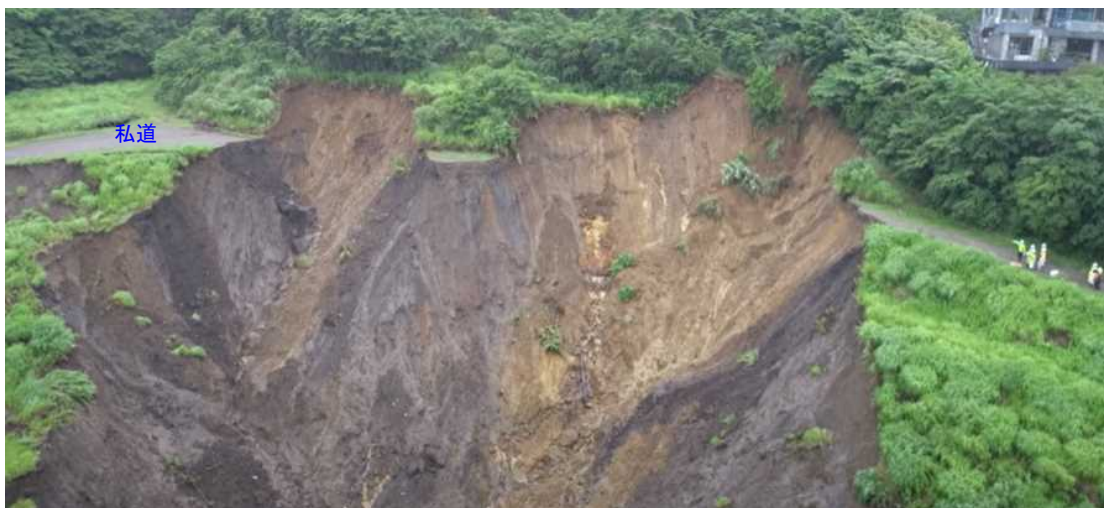
図 1-5 災害直後（7月3日）に撮影した崩落発生源域の UAV 撮影画像
