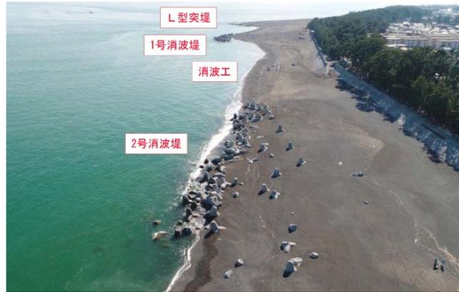
清水海岸 消波工沈下・飛散 (静岡市清水区三保)
