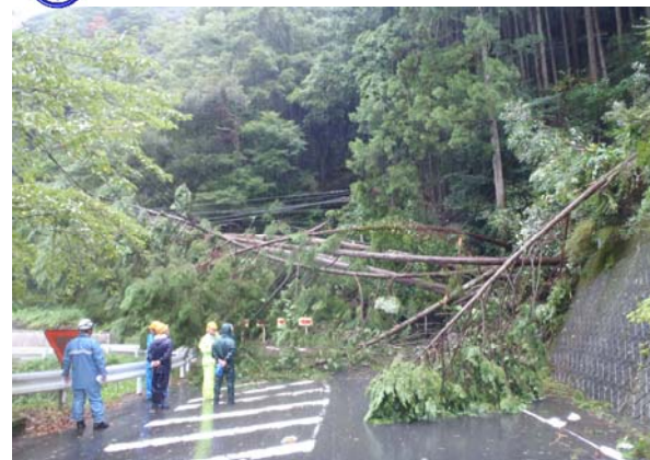
主要地方道伊東西伊豆線 法面崩壊（西伊豆町大沢里柵直畑）
