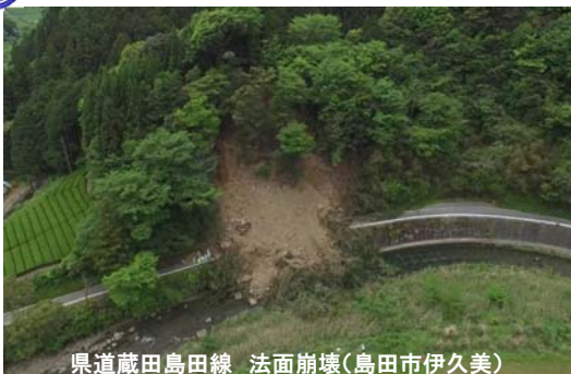
県道蔵田島田線 法面崩壊（島田市伊久美）
