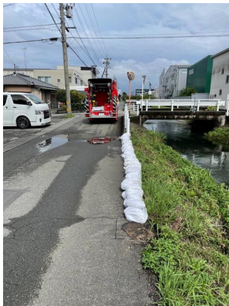
小石川左岸(築地671-1地先) 積み土のう工
