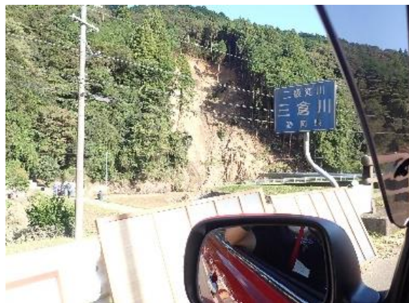
三倉川左岸の土砂崩れ避難誘導
