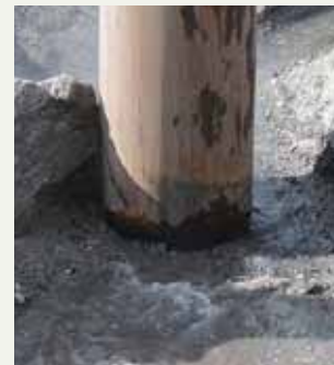
被圧地下水がある現場で、杭を施工した時の様子 杭の周辺から自噴水が湧き出ています
