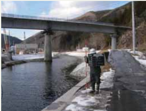
片岸川の護岸 (H 25.1 完成)
