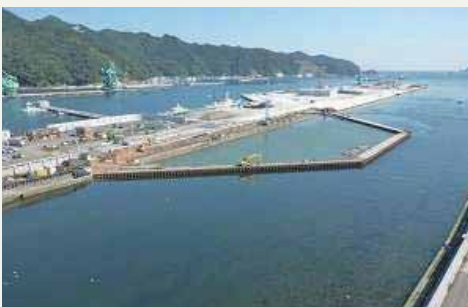
仮締切工事完了後の甲子川水門
