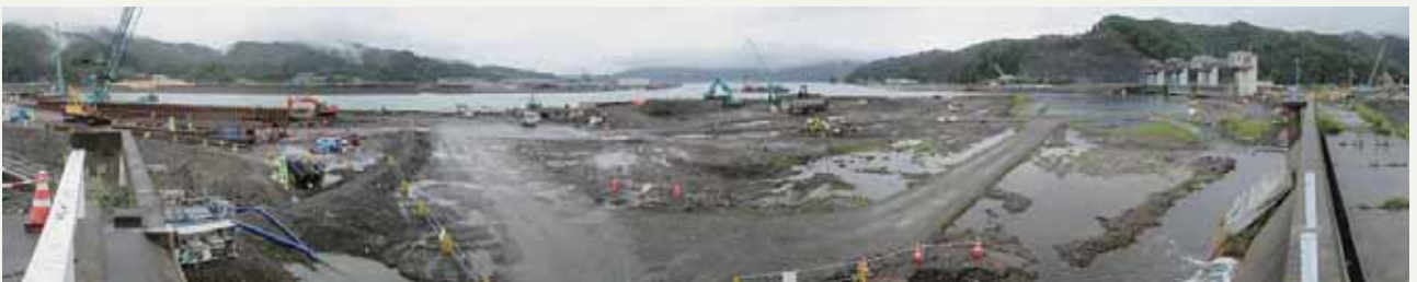
大槌川・小槌川の作業の様子。既設構造物の取壊しや、仮設矢板設置の真っ最中
