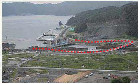
付替え後の小鍬川水門付近の様子
