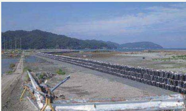
応急対策工事部(大型土のう約9,000個)
