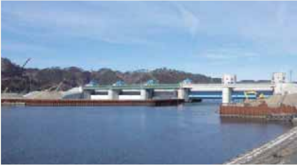
上流側より全景
