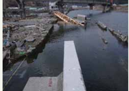
甲子川の被災状況
