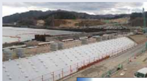
工事が進む織笠漁港海岸防潮堤
