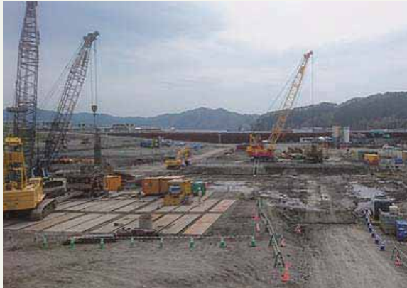
大槌川 水門基礎杭施工状況
