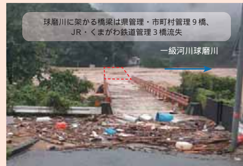
県道の橋梁(深水橋)流出(八代市坂本町西部)
