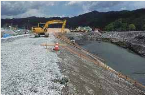
大槌川の転流前の状況
