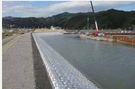
大槌川の転流後の状況。仮締切作業が続く
