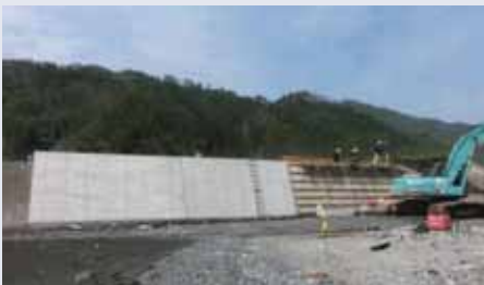
コンクリートの打設が始まる
