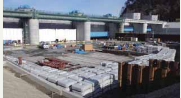
左岸仮締切内
