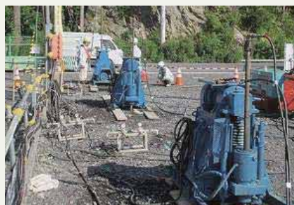
左) 薬液注入工の立会 右) 薬液注入工施工の様子 二重管ストレナーナ工法により施工
