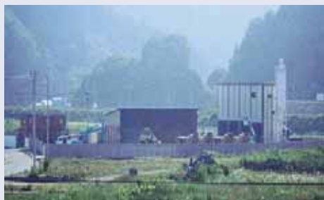
宮古市田老地区の仮設プラント
