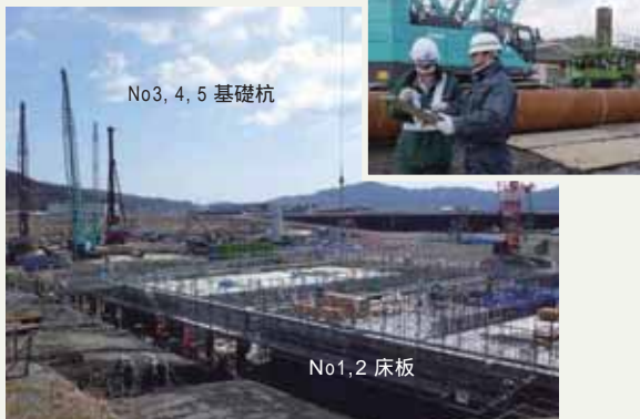
大槌川水門 現場状況
