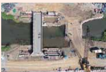
上部工横移動工
