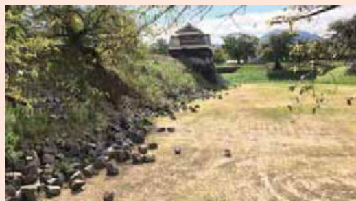
地震で崩落した熊本城の石垣
