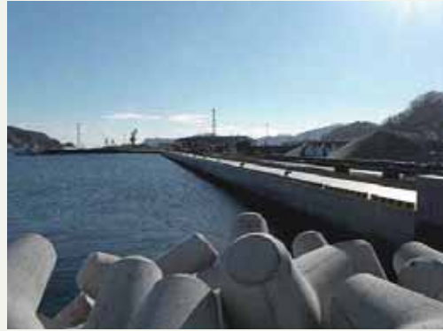
釜石港 -4 m 物揚場 (H 25.3 完成予定)
