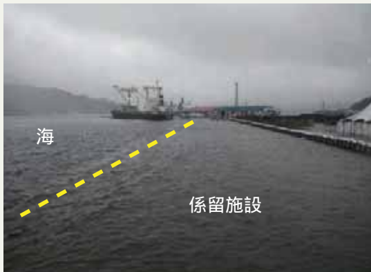
釜石港の浸水状況
