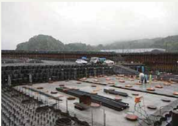
甲子川 基礎杭施工完了状況
