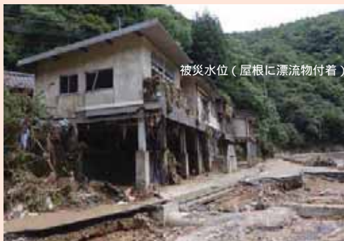
県道球磨田浦線の被災状況(葦北郡芦北町吉尾)
