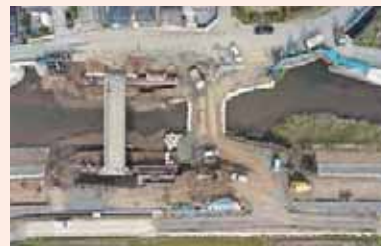
既設橋台撤去
