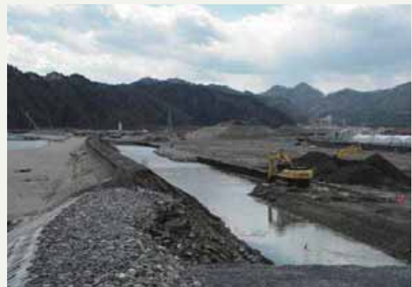
片岸海岸 基礎部掘削状況
