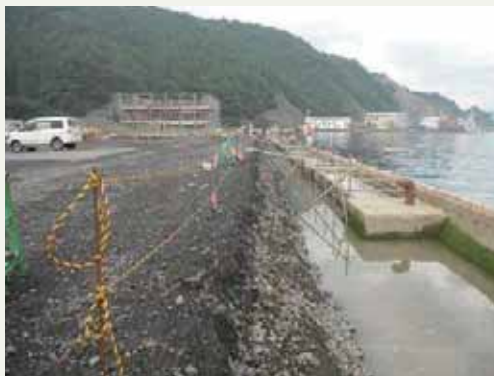
新しい魚市場と岸壁工事状況
