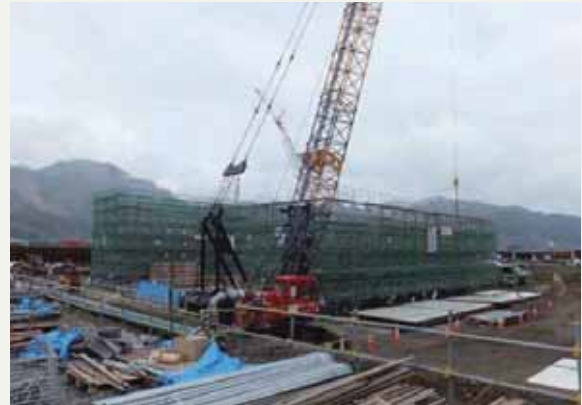
鵜住居川 水門コンクリート打設状況
