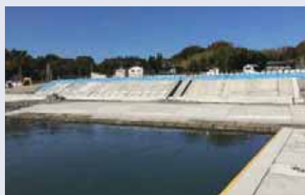
背後では織笠防潮堤が建設中
