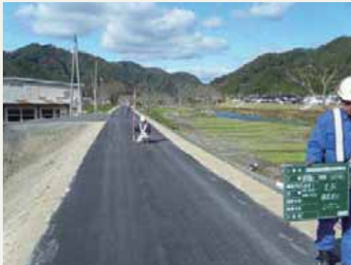
大槌川の堤防嵩上げと舗装 (H 24.10 完成)
