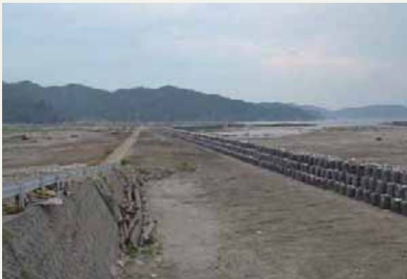
大型土のう約 9,000 個の設置が完了
