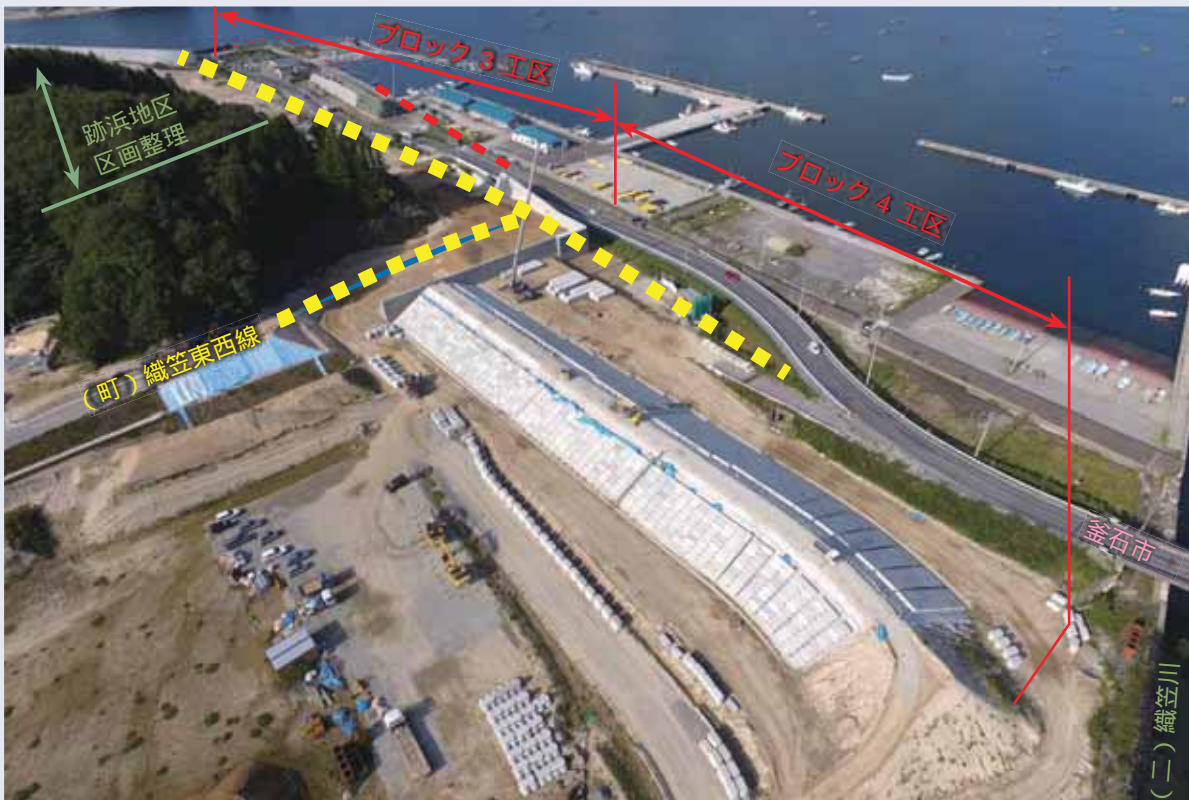
織笠漁港海岸防潮堤 ブロック 3、4 工区全景
