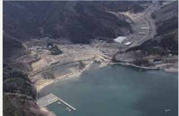
被災後の状況
