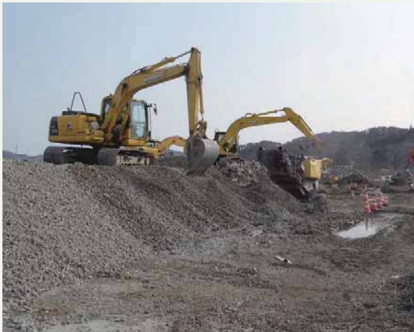
左) 大槌川防潮堤取壊し現場において、コンクリート殻から砕石を作る様子 上) 宮古港でのリサイクルコンクリート製作実験の様子(国土交通省)
