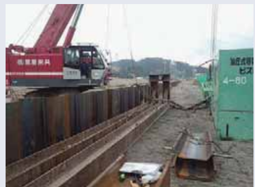
いよいよ防潮堤の工事が始まりました
