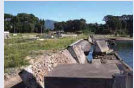
工事が始まる防潮堤 (緩傾斜堤建設地)
