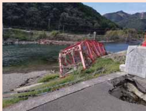
現在も河川内に取り残された橋桁
