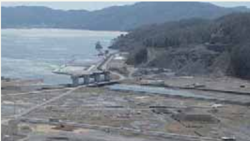
付替え前の小鍬川水門付近の道路（H26.4 撮影）
