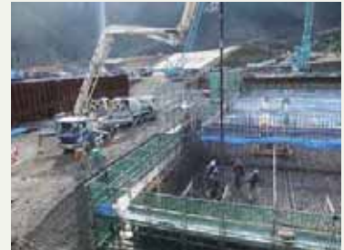
左) コンクリートポンプ車2台によるコンクリート打設 中) 現場立会い 右) ポンプ車打設
