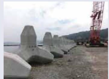
消波ブロック(15トン)の製作開始 同ブロックを500個以上製作予定
