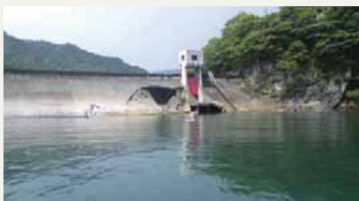
水海地先海岸防潮堤被災状況
