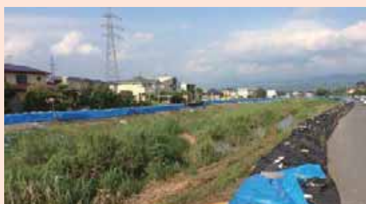
沈下した河川堤防に並べた大型土のう(秋津川)
