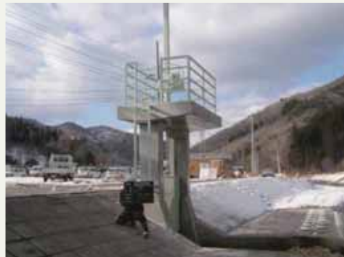
片岸川の樋管 (H 25.1 完成)
