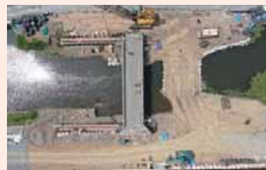
上部工横移動工
