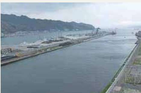
仮締切工事着手前の甲子川水門
