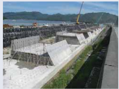
残存型枠の設置状況(第2ブロック) 万全の準備で生コンの供給を待つ
