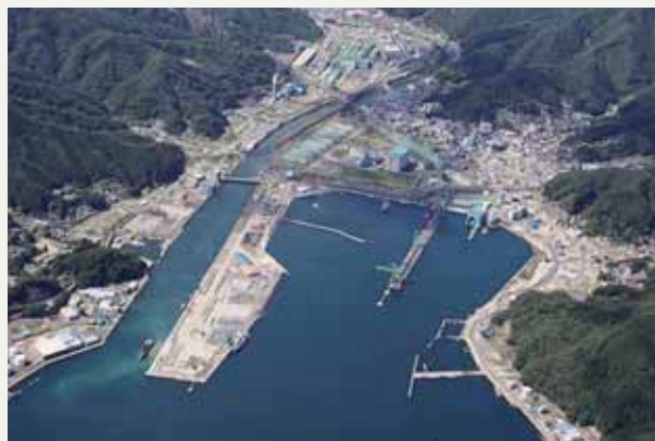
釜石港の状況
