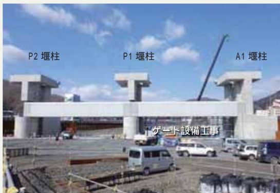
甲子川水門 現場状況
