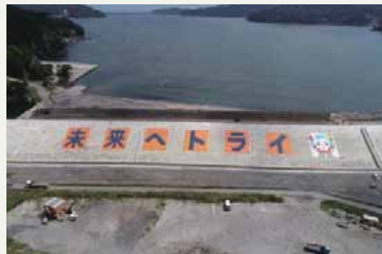
ラグビーW杯PRを兼ねた法面パネルの設置（釜石市）
