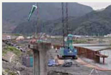
左) 鵜住居川 648 号現場全景 こちらも電動バイプロハンマにて鋼矢板を打設 右) 現場で打ち合せ
