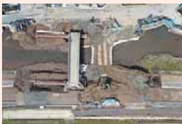
仮設ヤード及び仮設構台の設置
