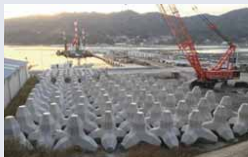
びっしりと並んだ消波ブロック 設置される時を待つ
