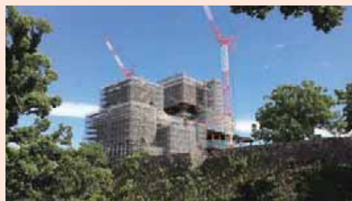
復旧工事が進む熊本城の本丸
