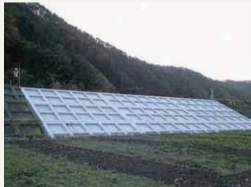
大槌川の護岸 (H 24.10 完成)
