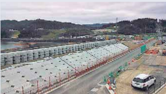
第1ブロックの進捗状況。あと3m程度盛土を行う
