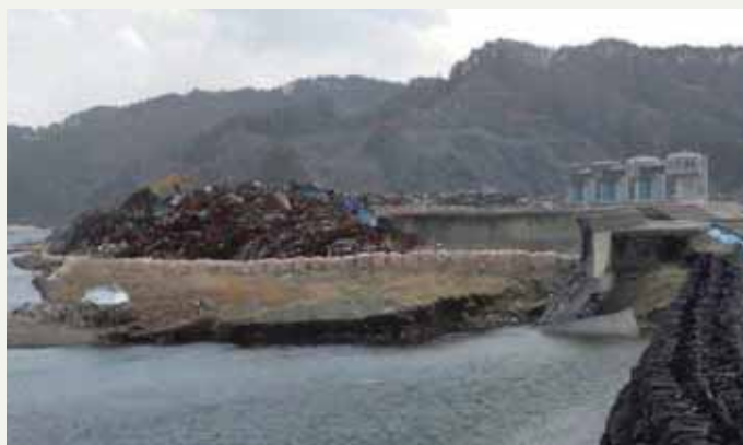
大槌川水門・小槌川水門の施工箇所 震災がれきの仮置場となっていた
