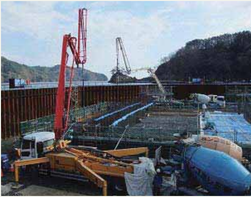
左) コンクリートポンプ車2台によるコンクリート打設 中) 現場立会い 右) ポンプ車打設
