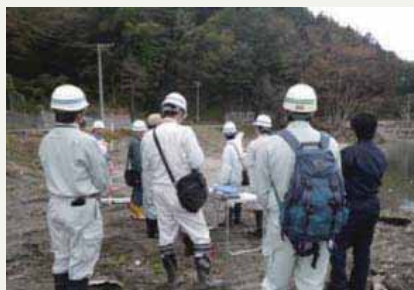
片岸地先海岸査定状況
