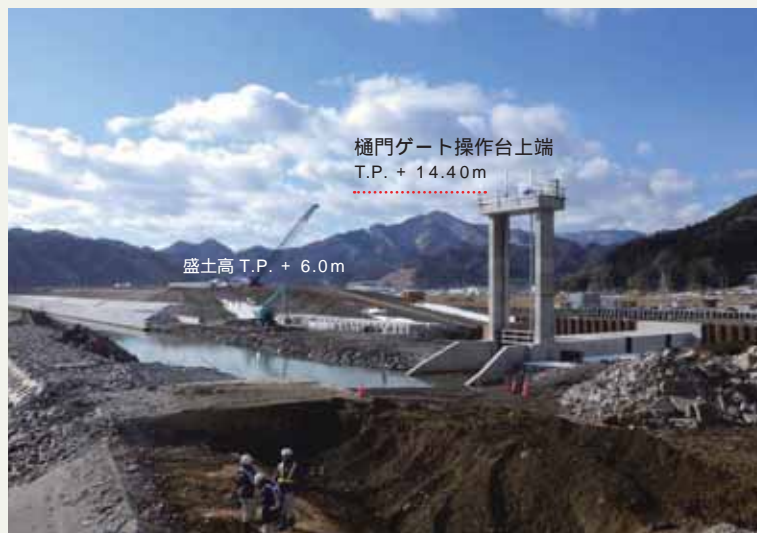
片岸海岸防潮堤工事 施工状況
