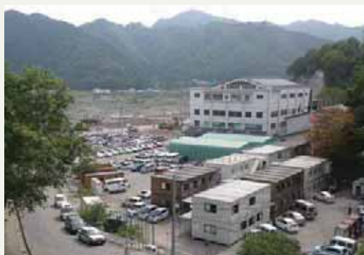
仮庁舎（手前のプレハブ建物）
