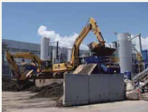
左) 原料となる津波堆積土砂をホッパーに投入 中) 石灰を入れて改良 右) 改良土の状態を確認
