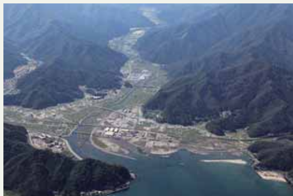
被災後の状況
