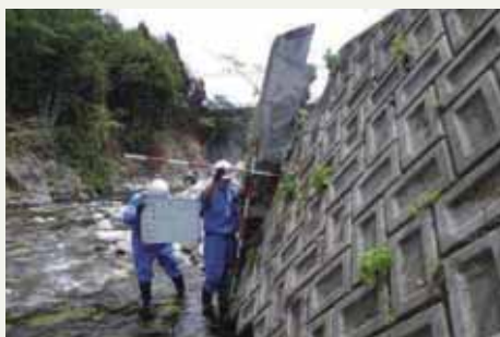
上左)片岸海岸...決壊した防潮堤(高さ約6.5m)現在、波の浸入防止に向けて大型土のう設置準備中
