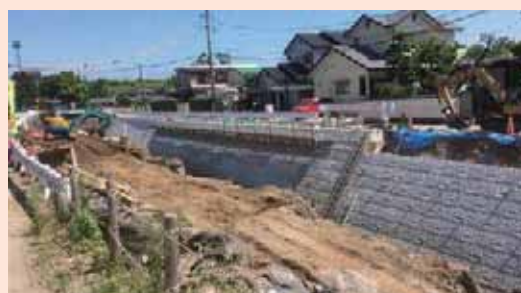
住宅密集地の護岸復旧工事(鉄砂川)
