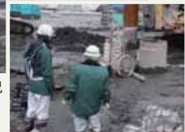
小槌川水門 現場状況
