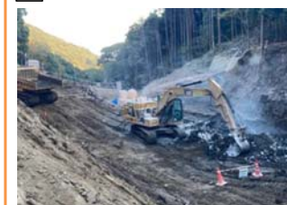
3 仮設ブロック堰堤②設置位置
