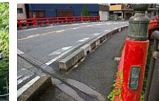
逢初橋(国道135号) ※2
