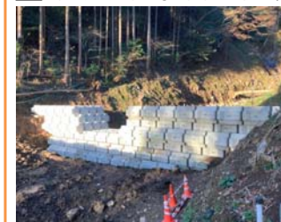
2 既設堰堤上流の掘削状況
