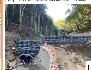
5 ネットロール土のう設置状況(完成)
