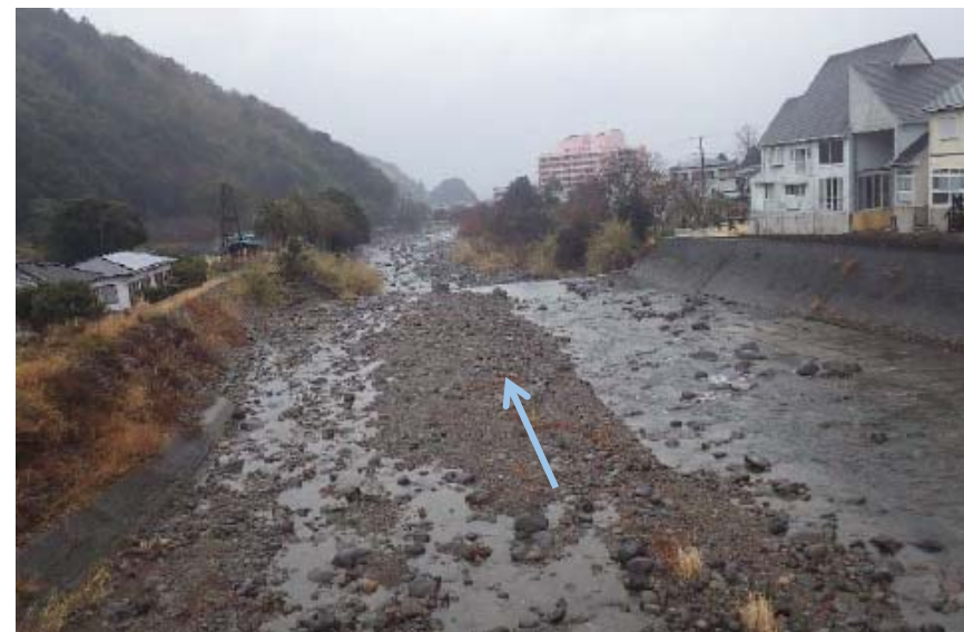
1.4K 付近橋梁より上流をのぞむ
