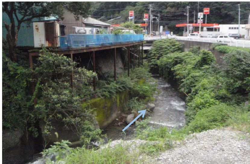
0.8k 付近より国道橋をのぞむ
