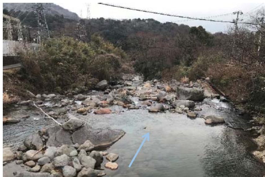
3.0k 堰口橋より下流をのぞむ
