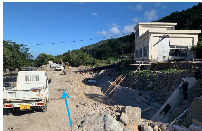
被災箇所の現状（災害復旧中）
