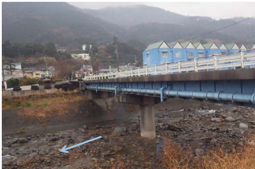
1.4k 付近左岸より湯ヶ岡赤川線橋をのぞむ
