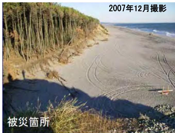
2007年7月の台風4号による堤防（土堤）の侵食状況
