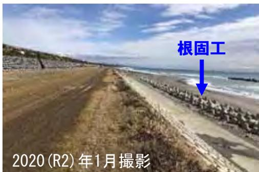
根固工設置例（竜洋海岸5～6号離岸堤間）
