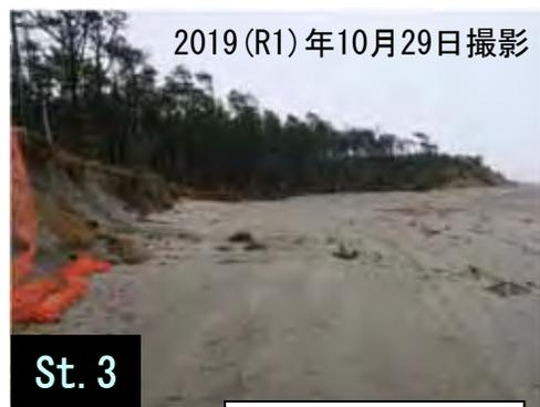
土堤が完全に削り取られ、平坦地が残されている。
