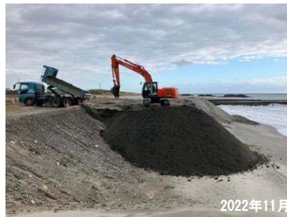
浜松篠原海岸の養浜実施状況 (秋葉ダム浚渫土砂)
