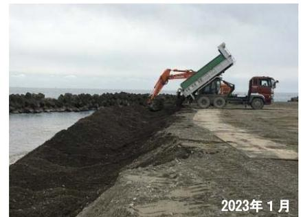
竜洋海岸の養浜実施状況 (天竜川河道掘削土砂)
