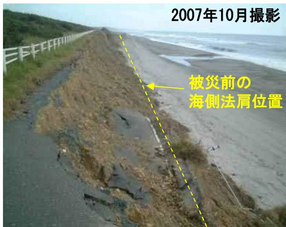
2007年7月の台風4号による堤防上自転車道の被災状況
