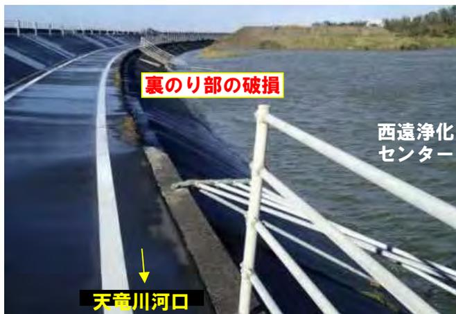
2013年10月の台風26号による越波による被害状況
