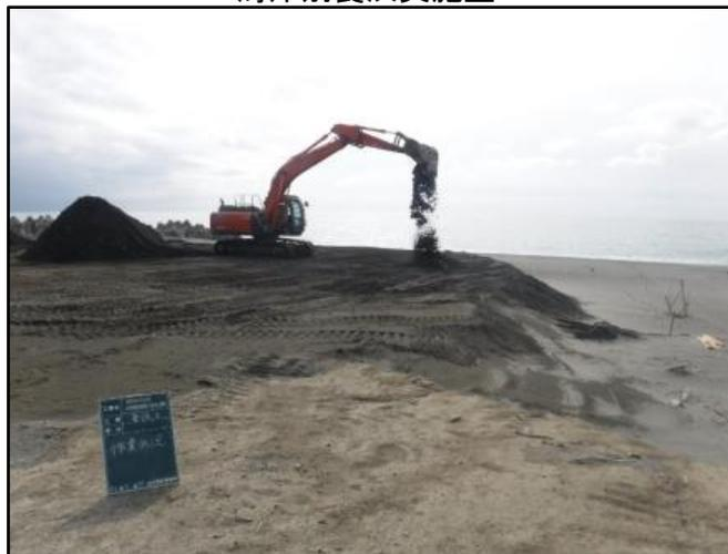
浜松五島海岸の養浜実施状況（秋葉ダム掘削土砂）
