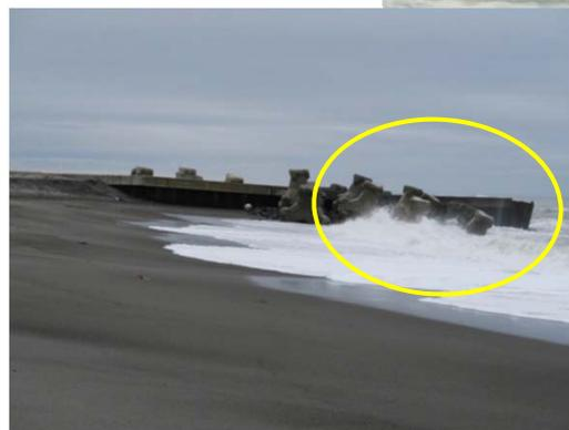
突堤左右の消波ブロックは、既に洗掘により沈下。突堤も早急に対策が必要。
