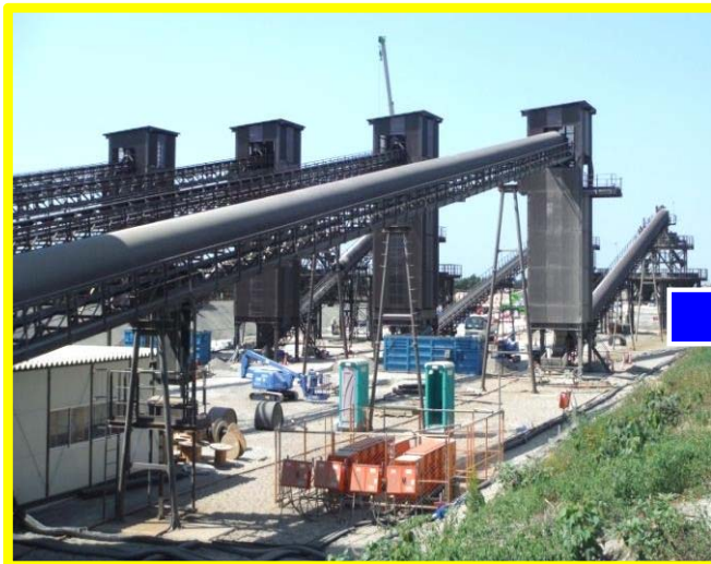
CSG製造プラント 及び CSG転圧状況 (本体施工①)
