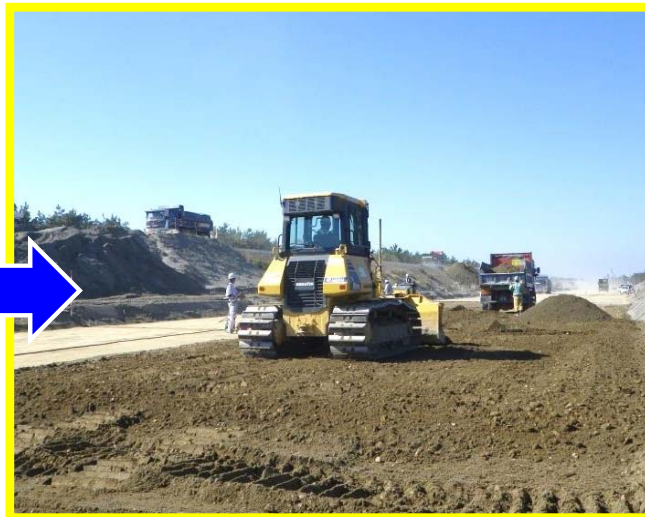
CSG製造プラント 及び CSG転圧状況 (本体施工①)
