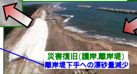
離岸堤下手に侵食波及 (砂浜消失)
