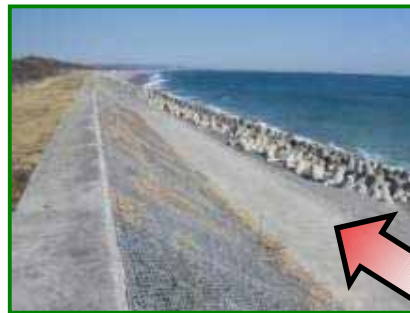
離岸堤下手に侵食波及 (砂浜消失)
