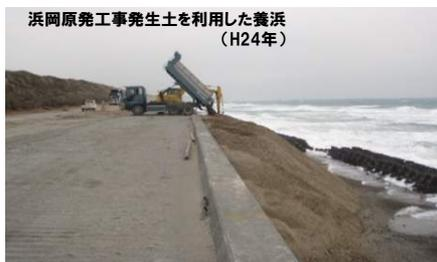
浜岡原発工事発生土を利用した養浜 (H24年)
