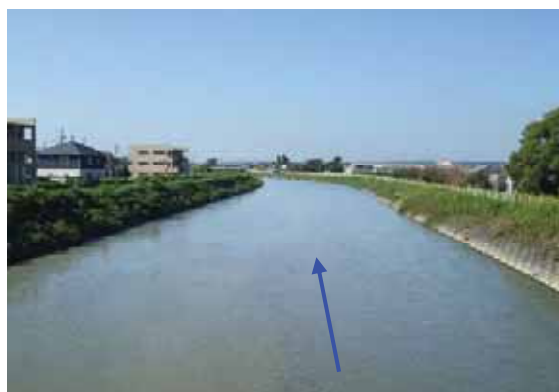
下流部の状況（十石橋から下流：河口から1.4km付近）
