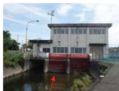
図 1-22 榛原第一排水機場
