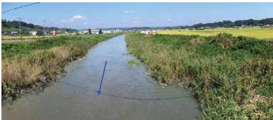
下流部の状況（佐々木橋より上流：河口から3.2km付近）
