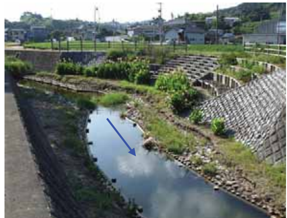
上流部の状況（河口から8.85km付近）
