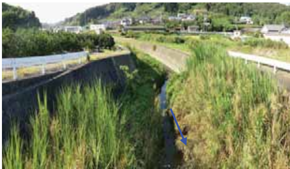
上流部の状況（河口から9.30km付近）
