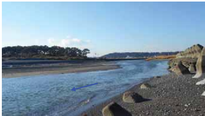
下流部の状況（河口部より0.1km付近）
