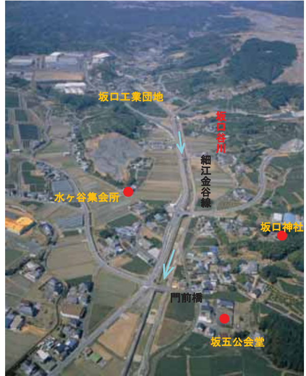
図 1-3 坂口谷川中・上流部 (8km 付近)
