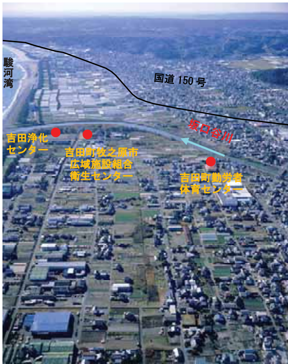
図 1-2 坂口谷川下流部
