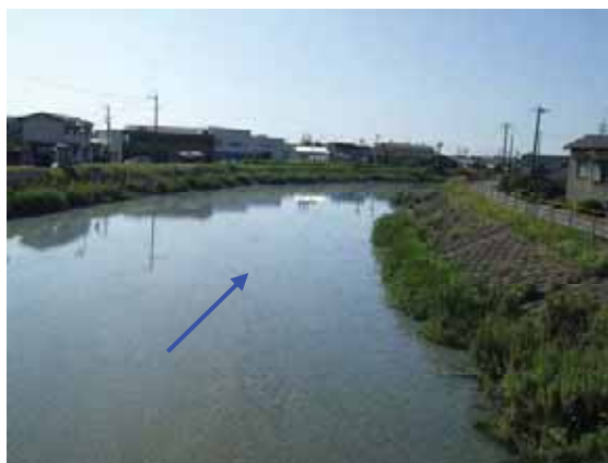
下流部の状況（井上橋より下流側：河口から2.0km付近）
