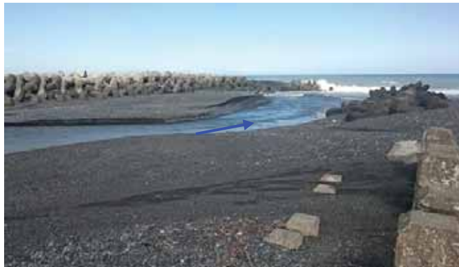
下流部の状況（河口部付近）
