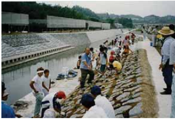
堂ヶ谷橋上流親水護岸整備
