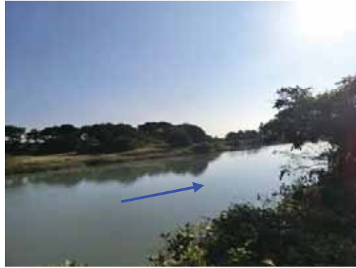
下流部の状況（河口部より0.4km付近）
