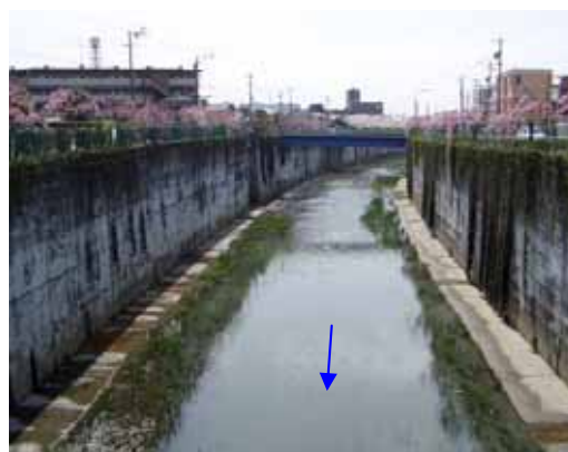
図 2-41 大谷川放水路の状況 - 駿河区小鹿 -
