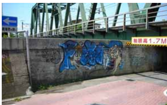
図 2-48 護岸への落書き -JR 橋付近-
