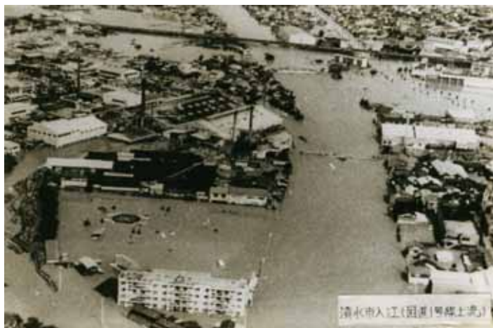
清水区入江 -国道1号付近-
