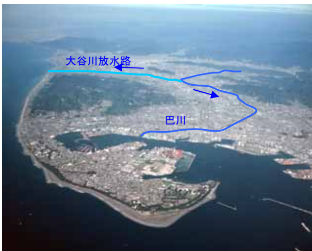
図 1-7 巴川下流部全景
