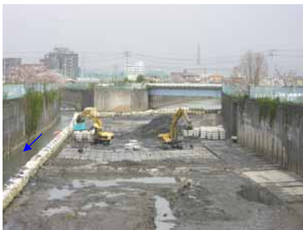
大谷川放水路の護床工 -駿河区富士見台-
