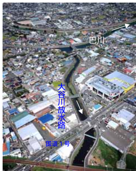
大谷川放水路分流堰 -葵区古庄-
