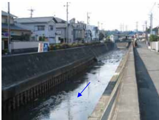
大沢川下流部の改修状況 -新追分橋付近-
