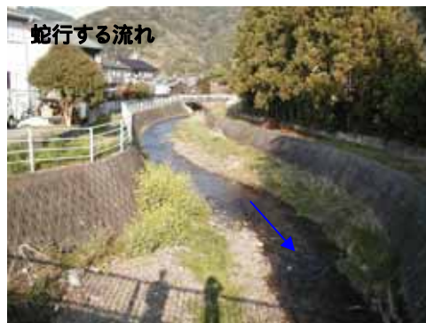
図 2-33 上流部の河道の状況 - 葵区北 -
