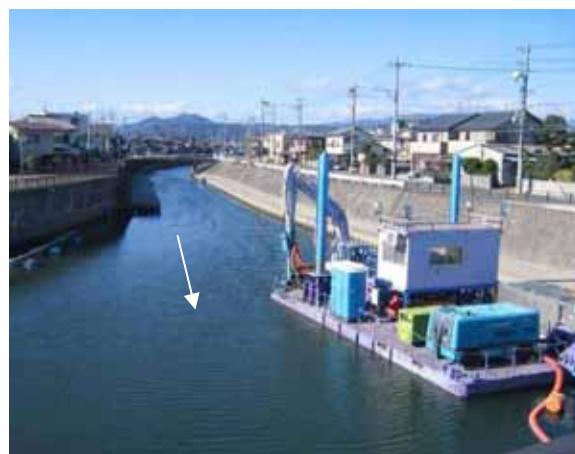
図 2-27 河川浄化の状況 (底泥の浚渫)
