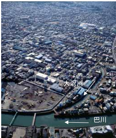
図 1-57 大沢川下流部 -清水区東大曲町付近-
