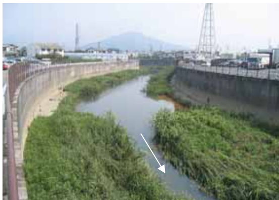
大谷川放水路 - 葵区古庄 2 丁目 -
