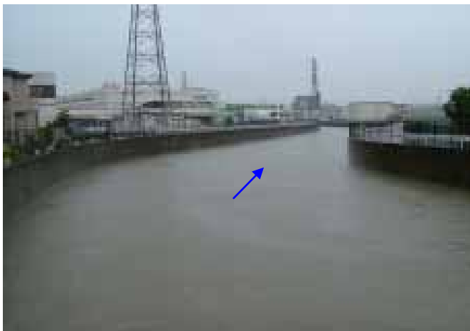
大谷川放水路 -葵区古庄-
