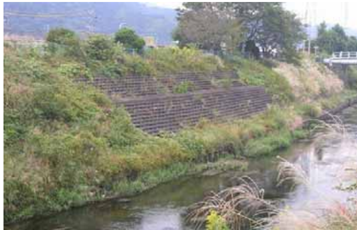
図 2-24 階段護岸の状況 -巴橋上流-
