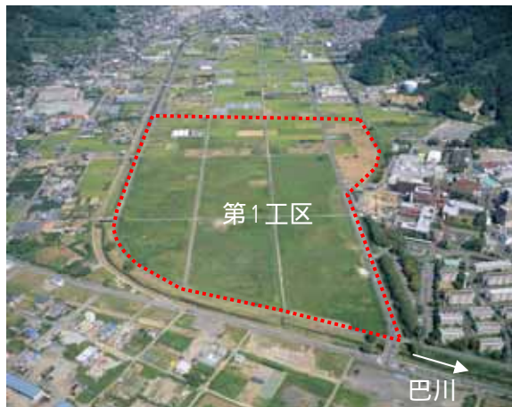
麻機遊水地第1工区の整備
