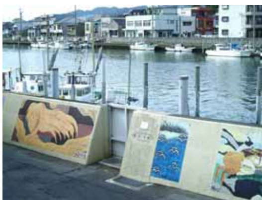
パラペット堤 -津波対策-
