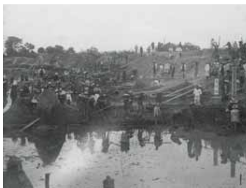
図 1-25 巴川の改修状況 -明治43年-
