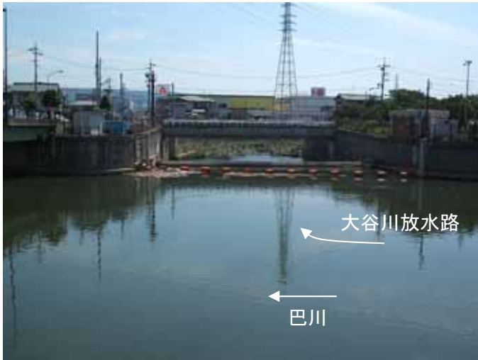
大谷川放水路分流工 - 葵区古庄 -
