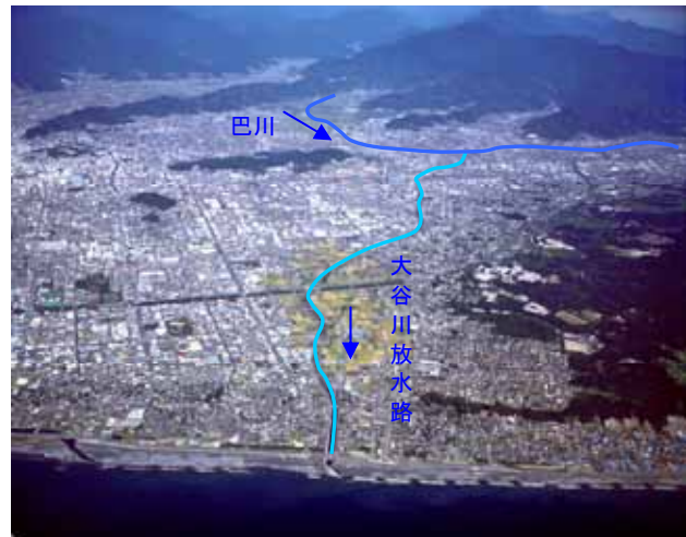
図 1-8 大谷川放水路全景
