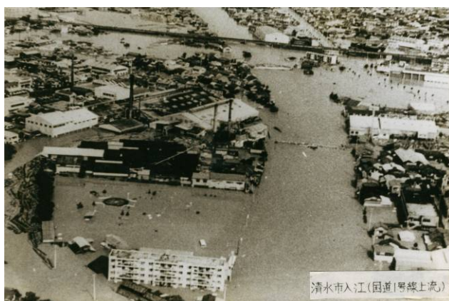
清水区入江（国道1号上流）
