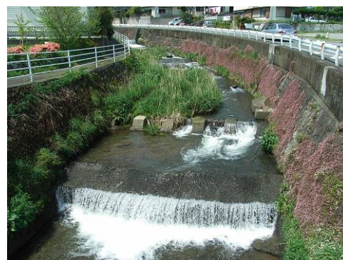
図-2.9 伊東宮川の取水堰跡
