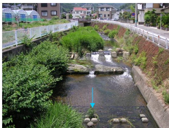
旧取水堰 0.4k 付近
