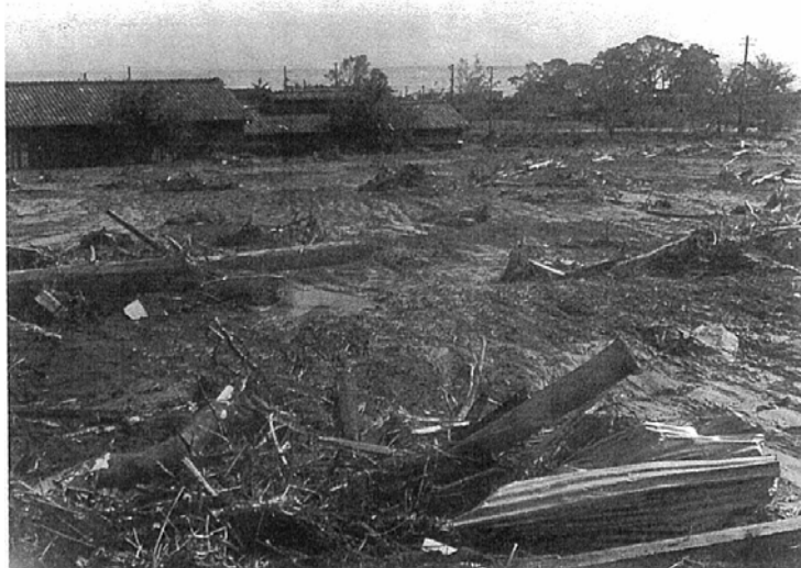
図-2.1 昭和33年 狩野川台風による被害状況 (宇佐美中学校校庭裏)
