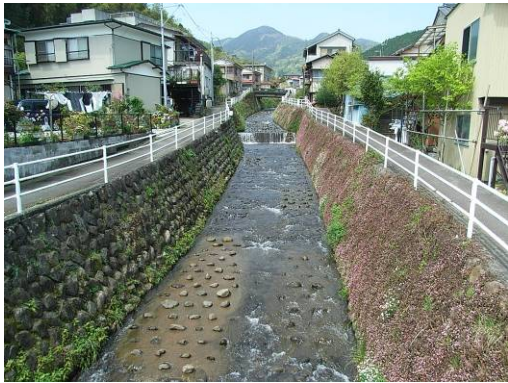
図-2.5 伊東仲川下流部河道の状況 (沿川に家屋が連担している)
