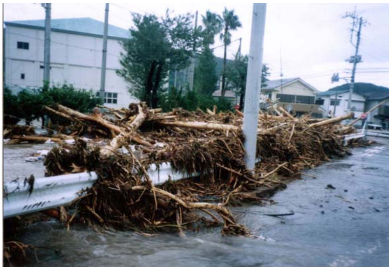
図-2.3 平成16年洪水による被害状況 (杉本橋上流に流木が堆積)
