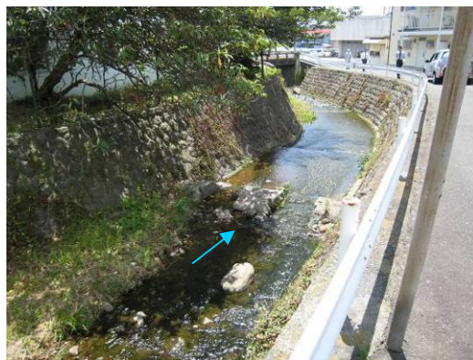
図-4.1 旧取水堰跡（伊東仲川 0.5k 付近）
