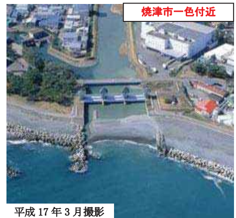
図 4-8 栃山川河口部の状況
