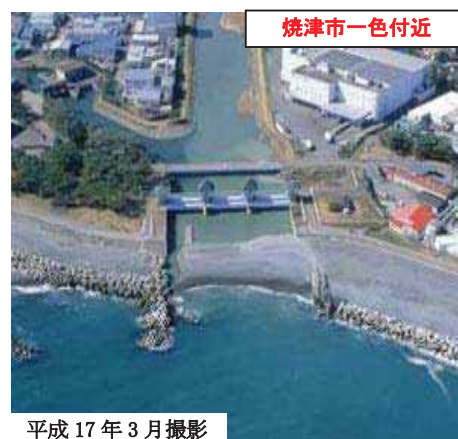
図 2-5 栃山川河口部の状況
