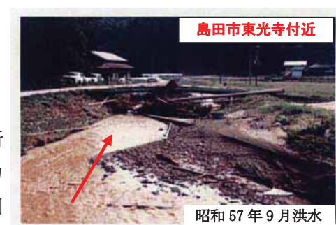
図 2-6 東光寺谷川被災状況
