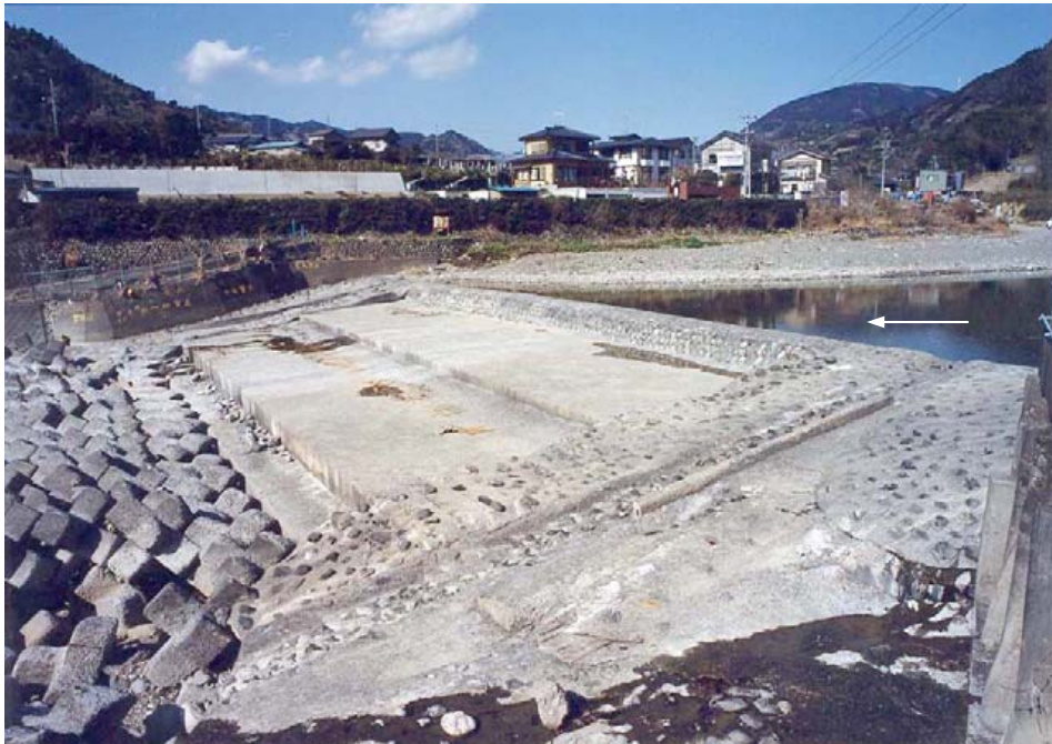
承元寺取水堰の状況 [平成 11 年 2 月撮影、静岡市清水区承元寺町地先]
