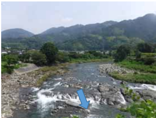
但沼町地先 公園と一体となった整備
