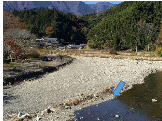
西里地先 緩傾斜護岸整備
