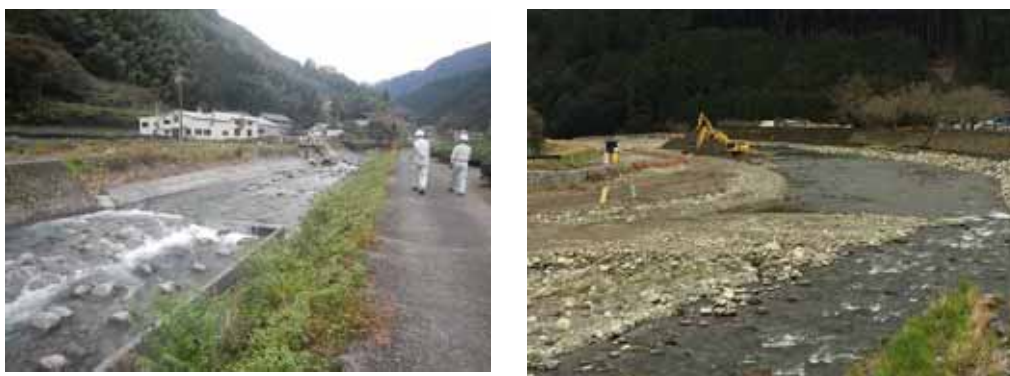
図 3.2.1 河川巡視・維持修繕の状況
