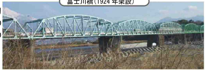
6径間鋼トラス橋(橋長399m)
