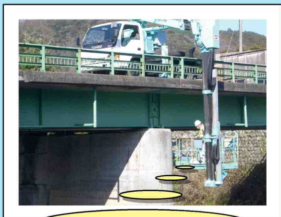
橋を点検している人
