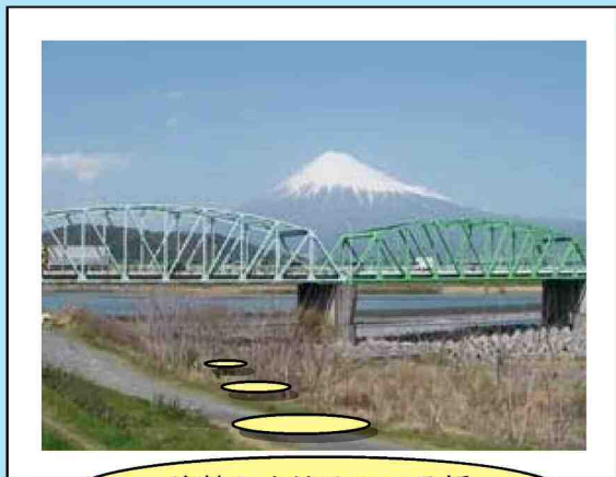
塗替えを始めている橋
