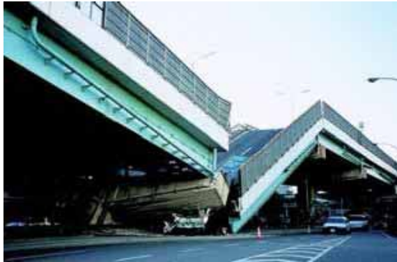
(a) シナリオA：下部構造が倒壊した例 14)
