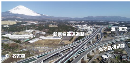
新東名 新御殿場JCT付近(御殿場市) 新東名高速道路・スマートICの概要図
