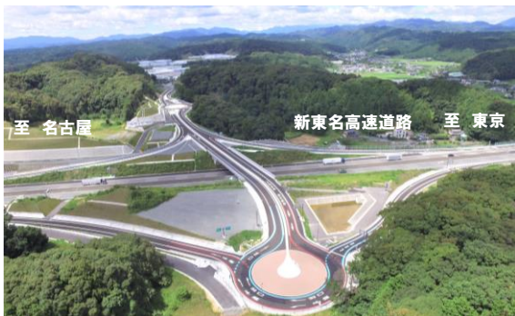
新磐田スマートIC 令和3年7月開通(磐田市)
