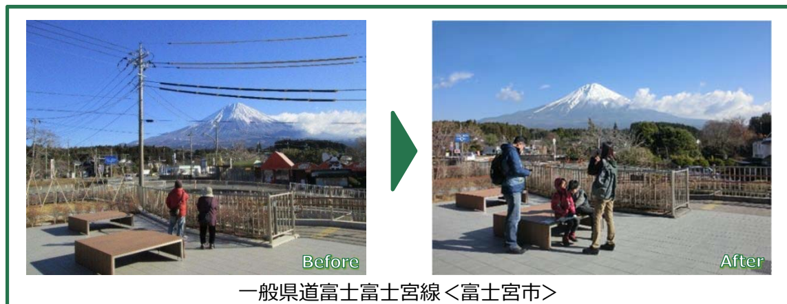
写真 2-1 県内の無電柱化実施箇所の事例
