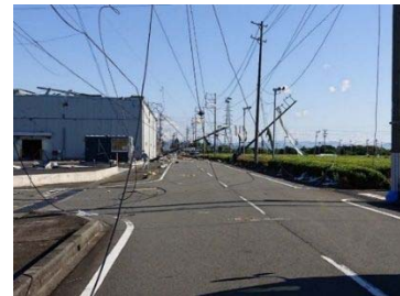
写真 2-2 道路を閉塞する電柱
