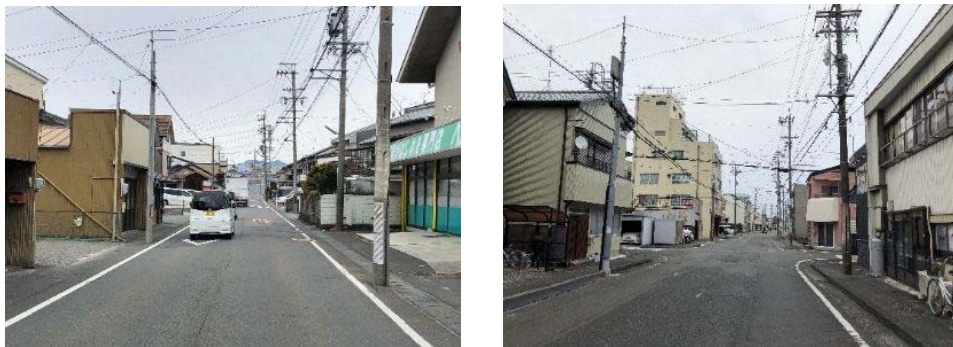
写真 3-3 地上機器の設置場所が確保できない道路の例
