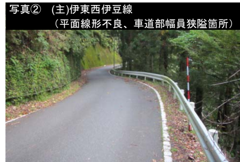
写真② (主)伊東西伊豆線 (平面線形不良、車道部幅員狭隘箇所) 見通しが悪くすれ違いが困難な区間
