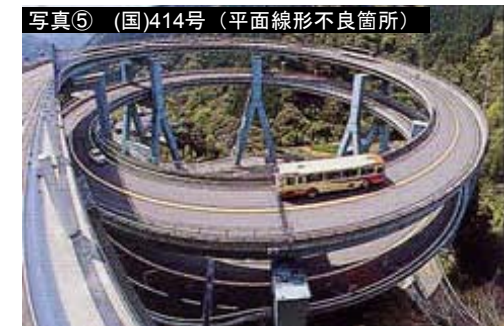
写真⑤ (国)414号 (平面線形不良箇所) 高低差45mを二重の螺旋カーブで結ぶ 河津七滝ループ橋 (R=40m)
