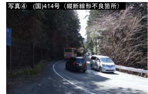
写真④ (国)414号 (縦断線形不良箇所) 縦断勾配 (i=9%以上)
