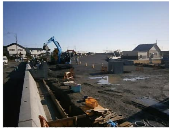
施工状況 上り線側ランプ
