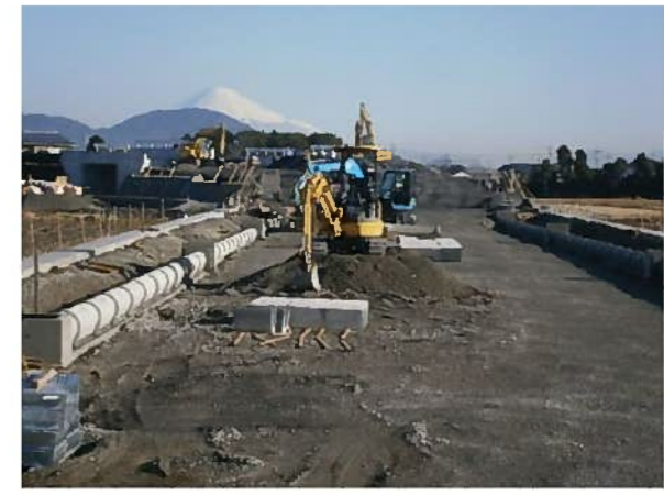
施工状況 下り線側ランプ
