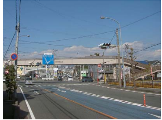
(国道 139 号 国久保横断歩道橋)
