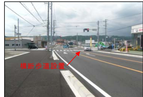
横断歩道の設置 (撤去後)
