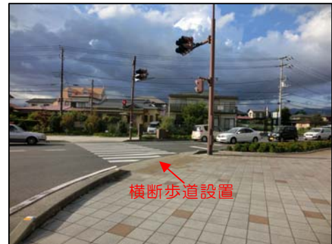
横断歩道の設置 (撤去後)
