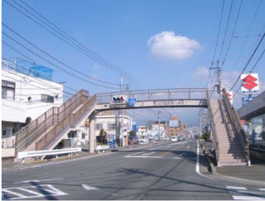
(国道 139 号 青島歩道橋)
