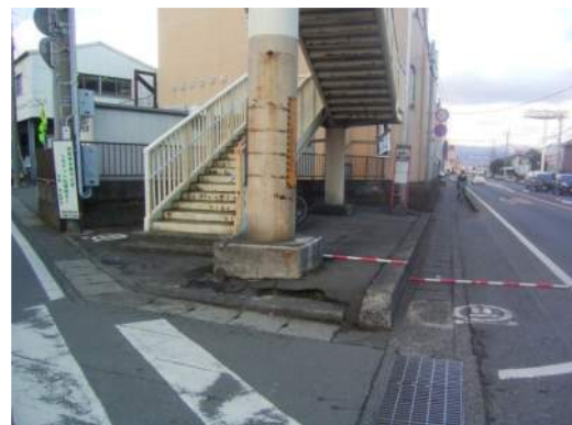
写真 4-2 歩道が狭くなっている事例
