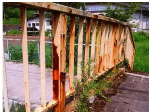
写真 4-4 高欄の腐食
