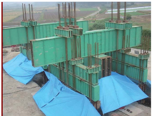
載荷試験状況
