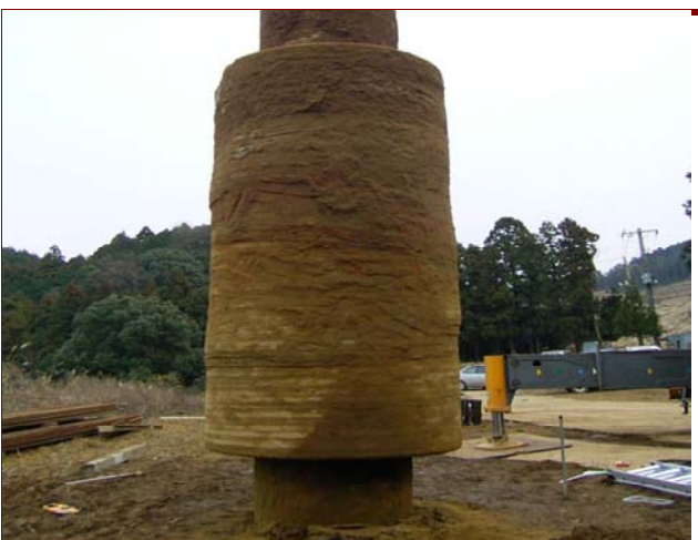
球根部掘起し試験状況
