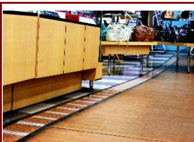
たわみ修正 施工前
