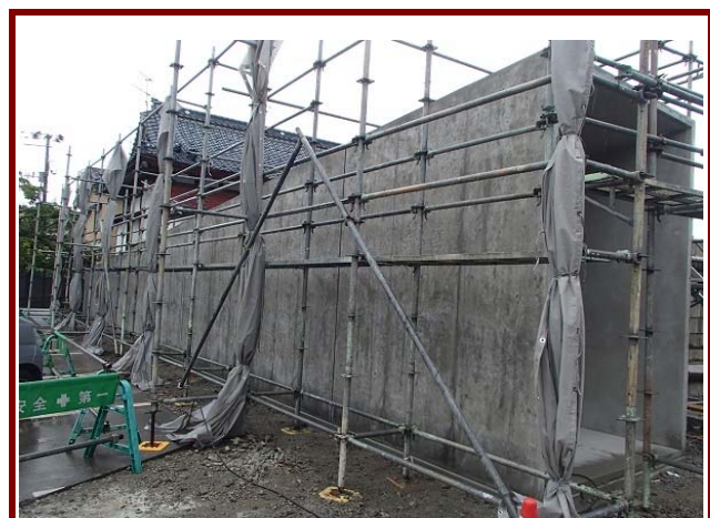
完成① 打ち放しコンクリートへの適用事例
