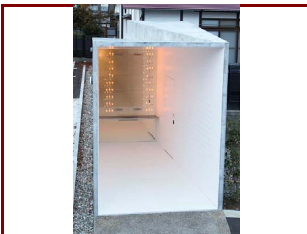
完成② 打ち放しコンクリートへの適用事例
