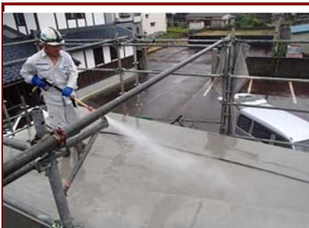
反応水散布工
