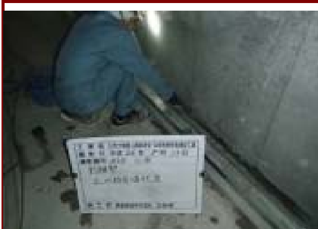
日大豊山新築工事-コンセントレート塗布工
