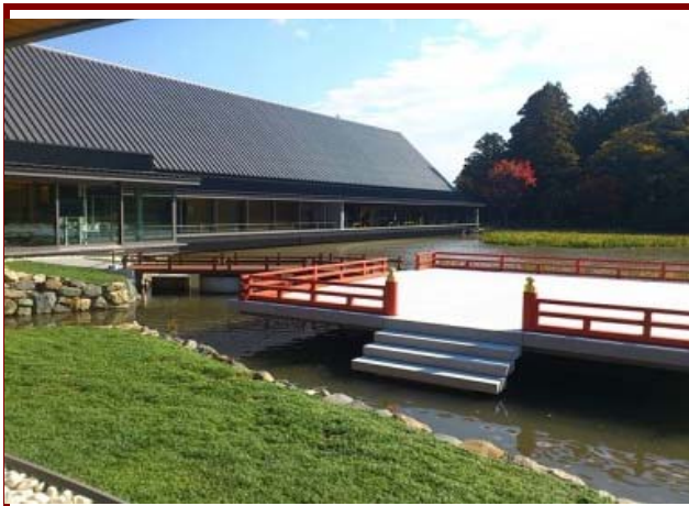
伊勢せんぐう館-完成状況
