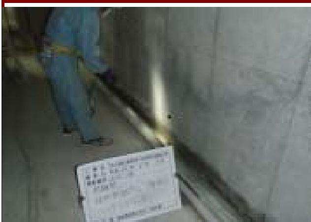
日大豊山新築工事-補助材散布工
