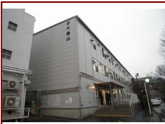
日大豊山新築工事-完成状況
