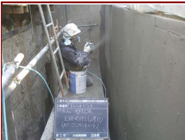
伊勢せんぐう館-コンセントレート吹付
